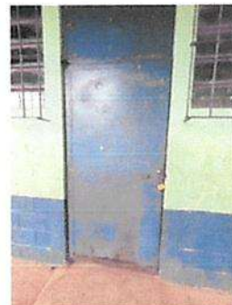
REPARACION Y MANTENIMIENTO A PUERTAS, SUSTITUCION DE CHAPA CERRADURAS, CHAPA YALE.
