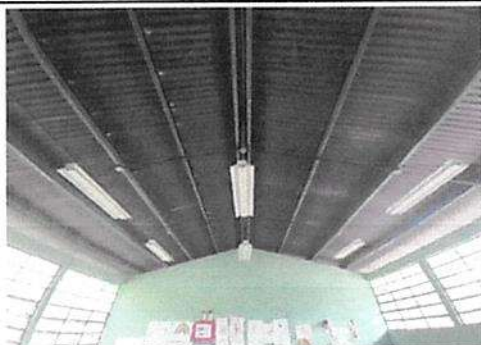
SUSTITUCION DE CUBIERTA DE LAMINA ACANALADA POR LAMINA TROQUELADA CALIBRE 26 ALUZINC ALUNAT
