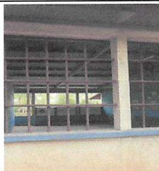
SUSTITUCION DE BALCONES DE METAL
