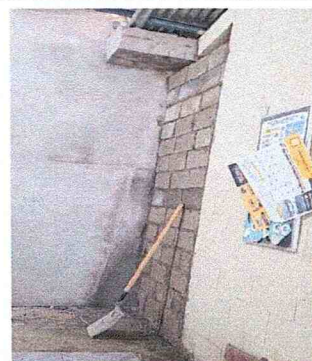
FOTO 4: REPELLO DE MURO. 30 metros cuadrados
