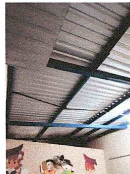
FOTO 2: MANTENIMIENTO A ESTRUCTURA DE SOPORTE DE METAL CON ANTICORROSIVO. 16 metros cuadrados.
