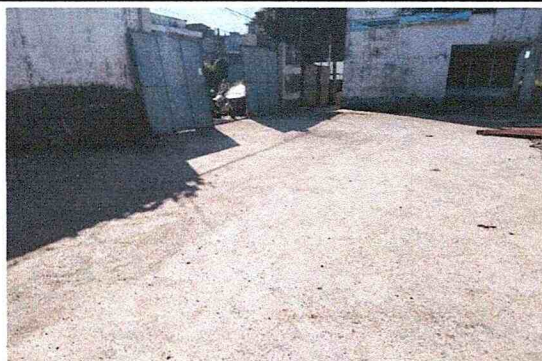
FOTO 13: SUSTITUCIÓN DE PISO DE TORTA DE CONCRETO
