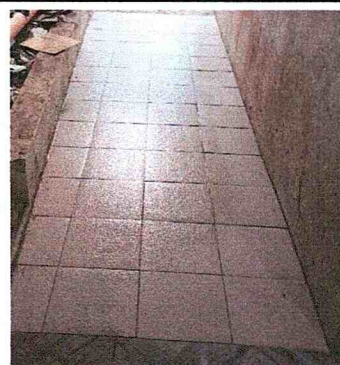
FOTO 14: SUSTITUCIÓN DE PISO CERÁMICO. 10.80 metros cuadrados
