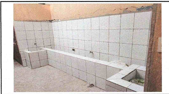
FOTO 10: SUSTITUCIÓN DE AZULEJO. 30 metros cuadrados.
