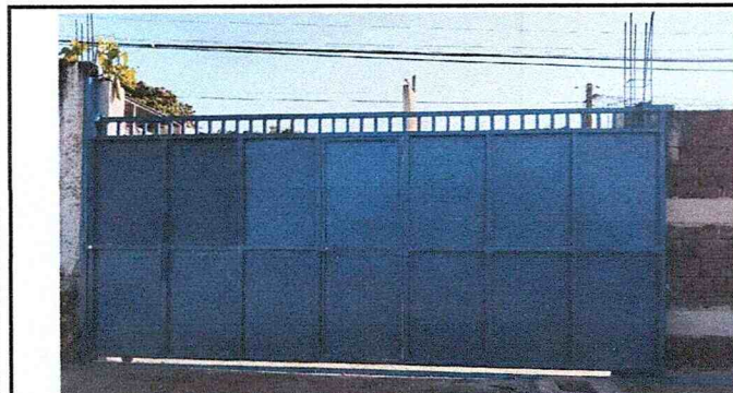
FOTO 5: SUSTITUCIÓN DE PORTÓN. Unidad
