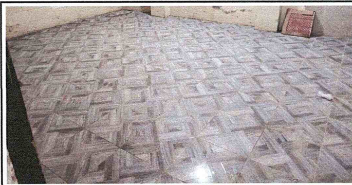
FOTO 6: SUSTITUCIÓN DE PISO CERÁMICO. 30 metros cuadrados
