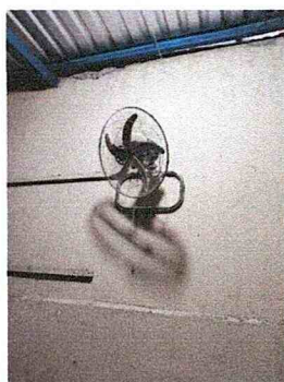
FOTO 15: SUSTITUCIÓN DE VENTILADOR DE PARED O TECHO (CLIMA CÁLIDO) 10 UNIDADES
