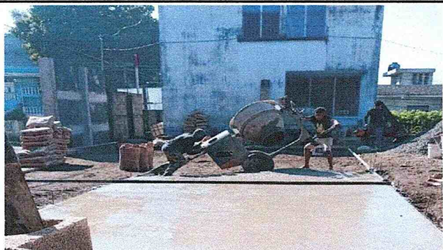
FOTO 13: SUSTITUCIÓN DE PISO DE TORTA DE CONCRETO
