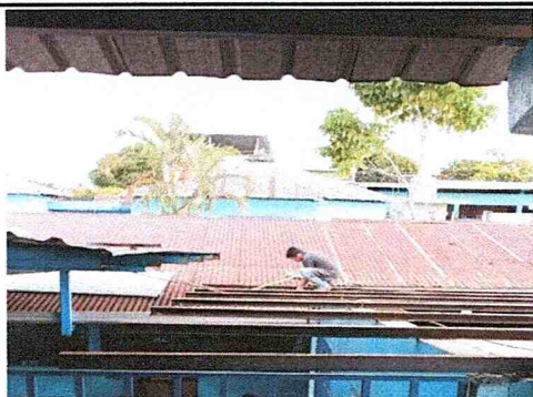
FOTO 11: SUSTITUCIÓN DE CAPOTE DE LÁMINA. 20 metros cuadrados
