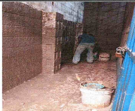
FOTO 4: REPELLO DE MURO. 30 metros cuadrados
