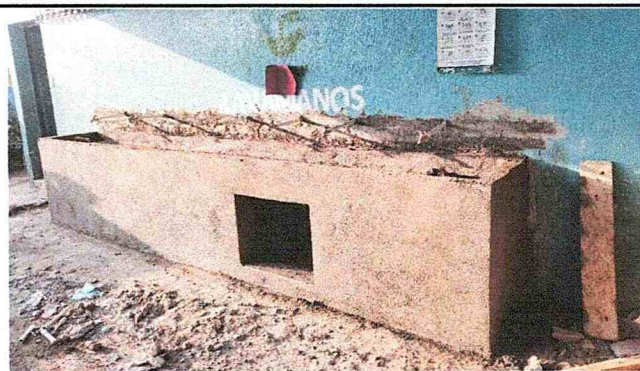
FOTO 8: SUSTITUCIÓN LAVAMANOS CON GRIFERÍA. 7 unidades
