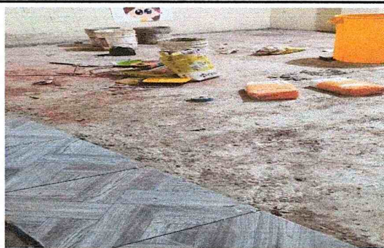
FOTO 6: SUSTITUCIÓN DE PISO CERÁMICO. 30 metros cuadrados
