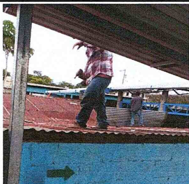
FOTO 1: SUSTITUCIÓN DE LÁMINA, POR LÁMINA TROQUELADA CALIBRE 26. 300 metros cuadrados.
