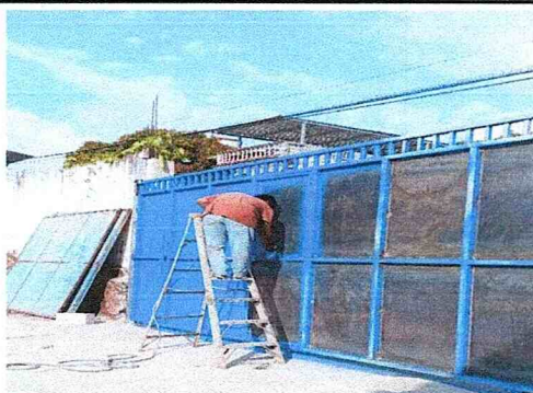
FOTO 5: SUSTITUCIÓN DE PORTÓN. Unidad
