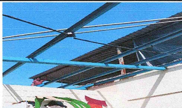
FOTO 2: MANTENIMIENTO A ESTRUCTURA DE SOPORTE DE METAL CON ANTICORROSIVO. 16 metros cuadrados.
