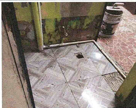
FOTO 7: SUSTITUCIÓN DE INODORO ELONGADO. Unidad
