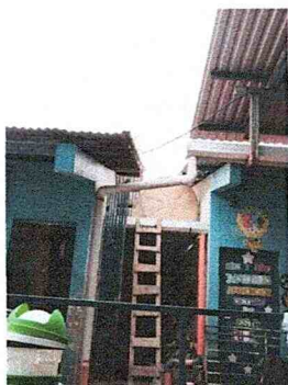
FOTO 9: SUSTITUCIÓN DE DEPÓSITOS DE AGUA 1000 LTS. Unidad
