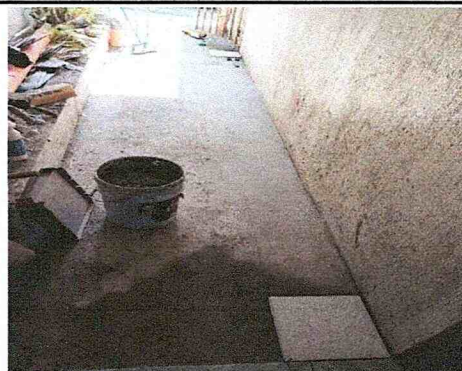
FOTO 14: SUSTITUCIÓN DE PISO CERÁMICO. 10.80 metros cuadrados
