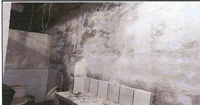
FOTO 12: REPELLO DE MURO. 90 metros cuadrados
