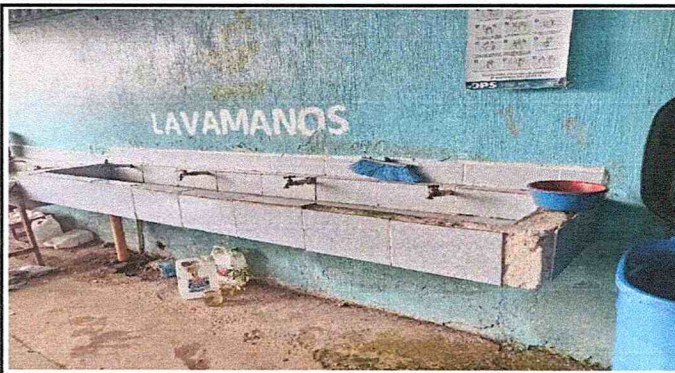
FOTO 8: SUSTITUCIÓN LAVAMANOS CON GRIFERIA. 7 unidades
