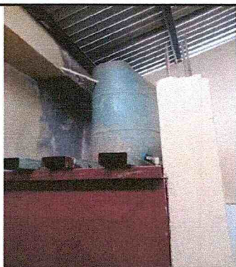
FOTO 9: SUSTITUCIÓN DE DEPÓSITOS DE AGUA 1000 LTS. Unidad
