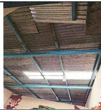
FOTO 2: MANTENIMIENTO A ESTRUCTURA DE SOPORTE DE METAL CON ANTICORROSIVO. 16 metros cuadrados.
