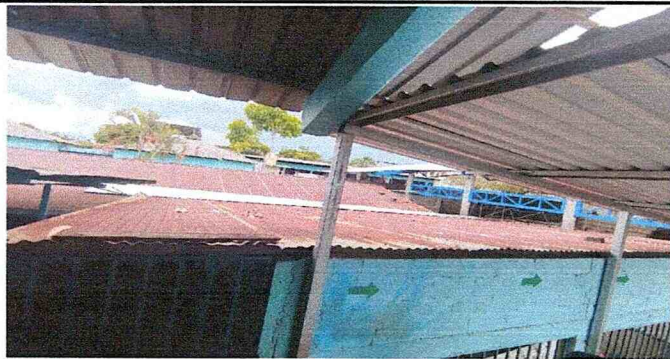
FOTO 11: SUSTITUCIÓN DE CAPOTE DE LÁMINA. 20 metros cuadrados
