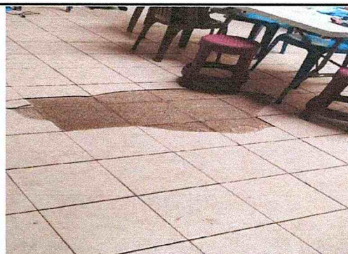
FOTO 6: SUSTITUCIÓN DE PISO CERÁMICO. 30 metros cuadrados
