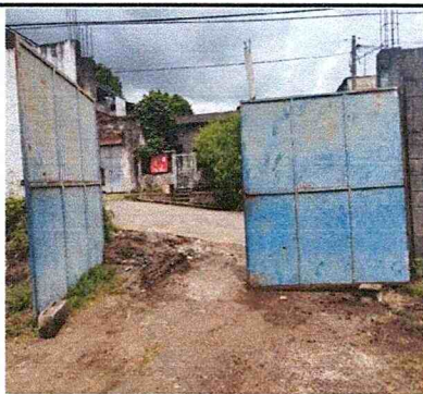
FOTO 5: SUSTITUCIÓN DE PORTÓN. Unidad
