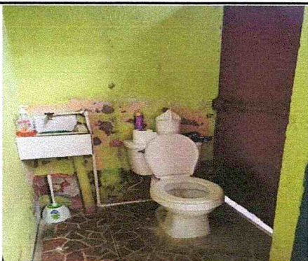
FOTO 7: SUSTITUCIÓN DE INODORO ELONGADO. Unidad
