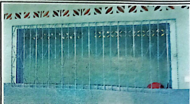
Foto # 2: MANTENIMIENTO DE BALCONES. 45 M2
