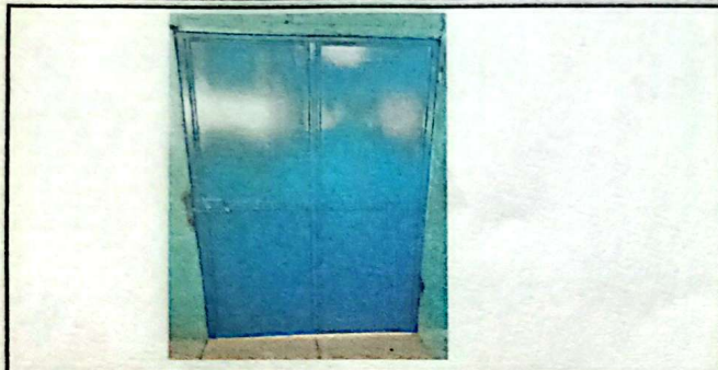
Foto # 1: SUSTITUCIÓN DE PUERTAS DE AULAS. 5 Unidades
