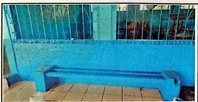
Foto # 5: SUMINISTRO Y APLICACIÓN DE PINTURA CELESTE PANTONE EN MUROS INTERIORES Y EXTERIORES. 600 M2
