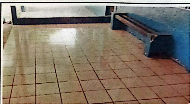
Foto # 4: SUSTITUCIÓN DE PISO DE CONCRETO POR PISO CERÁMICO. 165 M2
