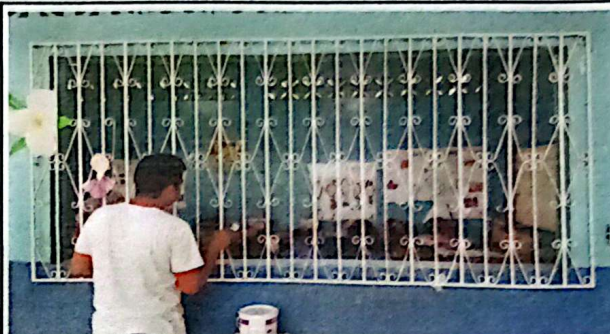
Foto # 2: MANTENIMIENTO DE BALCONES. 45 M2
