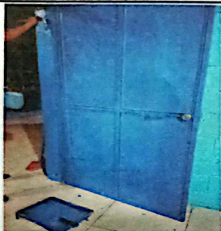
Foto # 1: SUSTITUCIÓN DE PUERTAS DE AULAS. 5 Unidades
