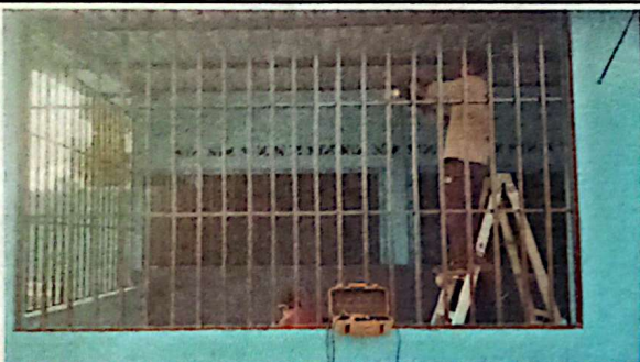
Foto # 3: SUSTITUCIÓN DE BARANDA DE PASILLO. 15 M2
