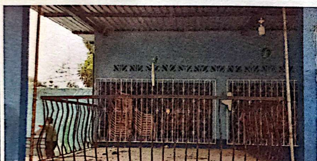
Foto # 3: SUSTITUCIÓN DE BARANDA DE PASILLO. 15 M2
