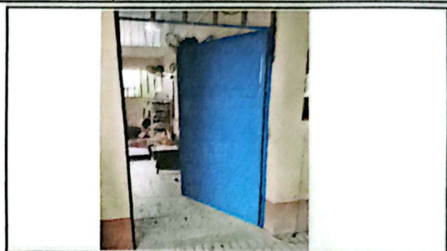
Foto # 8 SUSTITUCIÓN DE PUERTAS DE AULAS. 7 UNIDADES
