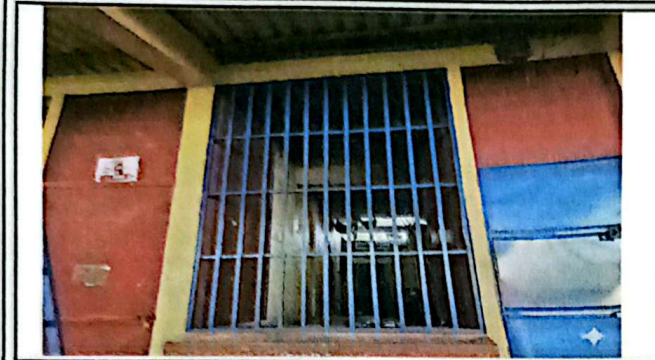
Foto # 7 SUSTITUCIÓN DE BALCONES. 3.2 M2
