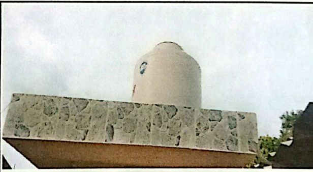
Foto #4 MANTENIMIENTO CORRECTIVO DEPOSITO DE AGUA, ACCESORIOS Y TUBERÍA. 1 UNIDAD
