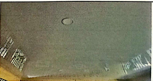
Foto # 6 REPARACIÓN DE CUBIERTA CON CIELO FALSO PVC. 191 ML
