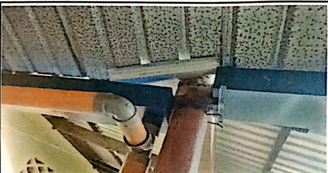
Foto # 3 SUSTITUCIÓN DE CANAL DE PVC POR CANAL DE METAL. 55 ML
