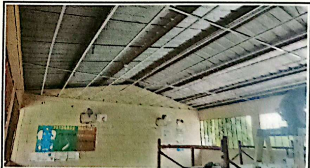
Foto # 6 REPARACIÓN DE CUBIERTA CON CIELO FALSO PVC. 191 ML
