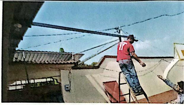
Foto #1 SUSTITUCIÓN DE LAMINA, POR LAMINA TROQUELADA CAL.26. 15 M2
