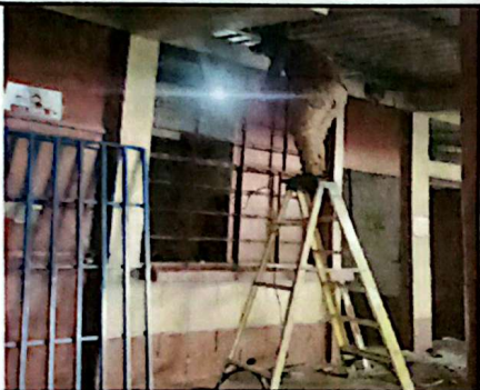
Foto # 7 SUSTITUCIÓN DE BALCONES. 3.2 M2
