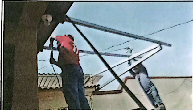
Foto# 2 SUSTITUCIÓN DE ESTRUCTURA DE SOPORTE DE MADERA, POR METAL. 15 M2
