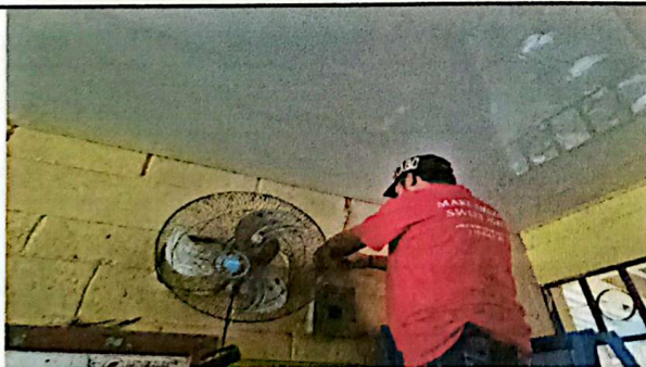
Foto # 5 SUSTITUCIÓN CABLEADO ELÉCTRICO CAL. 10 Y 12 AWG. 280 ML
