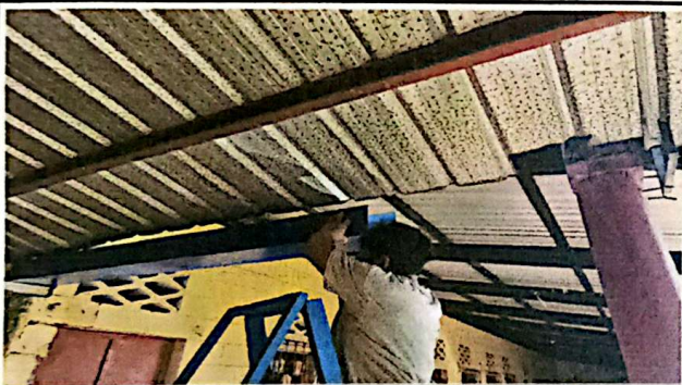
Foto # 3 SUSTITUCIÓN DE CANAL DE PVC POR CANAL DE METAL. 55 ML
