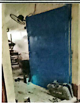
Foto # 8 SUSTITUCIÓN DE PUERTAS DE AULAS. 7 UNIDADES
