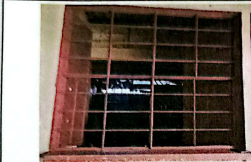
Foto # 7 SUSTITUCIÓN DE BALCONES. 3.2 M2
