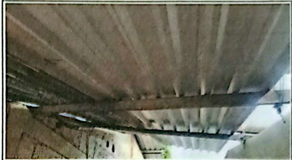
Foto# 2 SUSTITUCIÓN DE ESTRUCTURA DE SOPORTE DE MADERA, POR METAL. 15 M2
