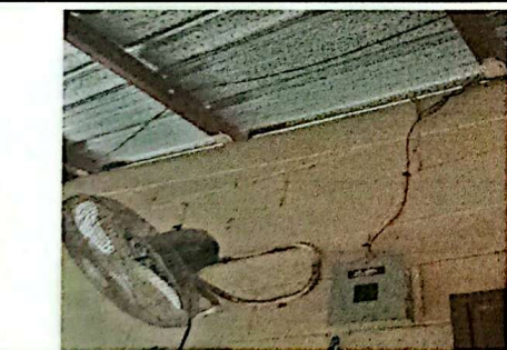
Foto # 5 SUSTITUCIÓN CABLEADO ELÉCTRICO CAL. 10 Y 12 AWG. 280 ML
