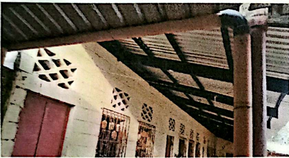
Foto # 3 SUSTITUCIÓN DE CANAL DE PVC POR CANAL DE METAL. 55 ML
