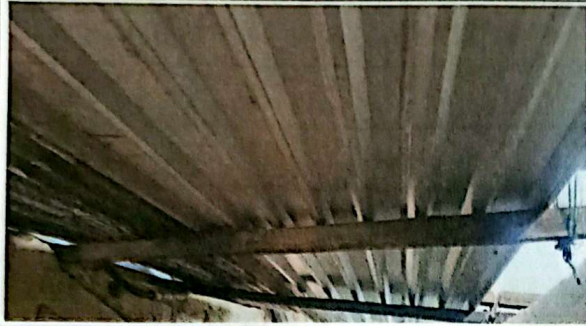
Foto #1 SUSTITUCIÓN DE LAMINA, POR LAMINA TROQUELADA CAL.26. 15 M2
