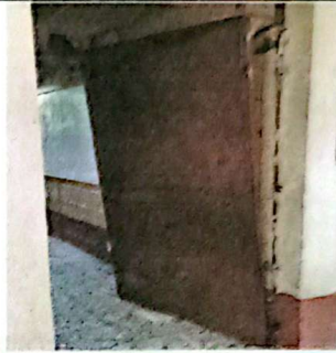
Foto # 8 SUSTITUCIÓN DE PUERTAS DE AULAS. 7 UNIDADES
