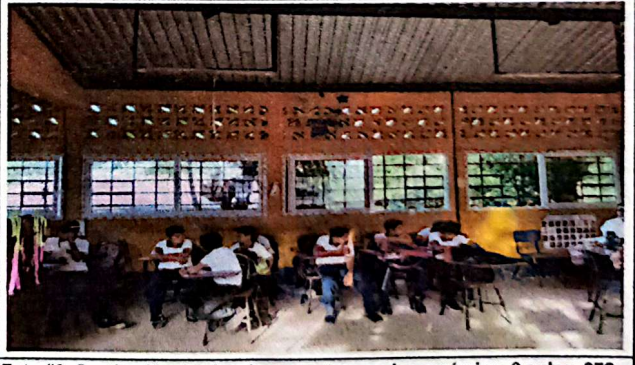
Foto #6: Sustitución de piso de concreto por piso cerámico. 9 aulas, 378 m2
