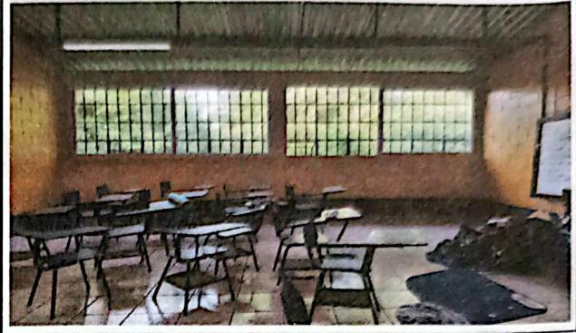
Foto #2: Sustitución de ventanas de metal por ventanas pvc. 25 ventanas, 74.3 m2
