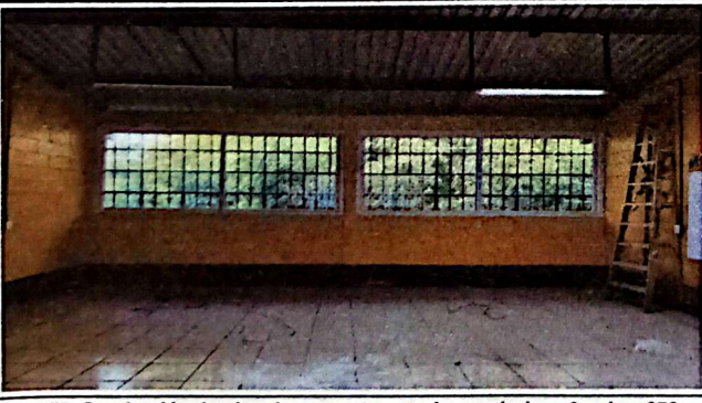
Foto #5: Sustitución de piso de concreto por piso cerámico. 9 aulas, 378 m2
