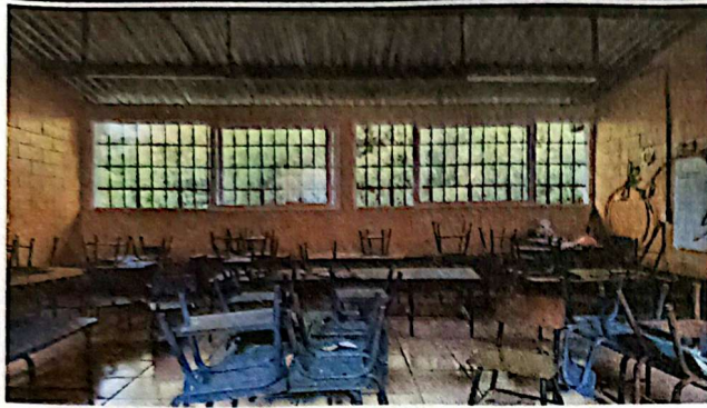
Foto #1: Sustitución de ventanas de metal por ventanas pvc. 25 ventanas, 74.3 m2
