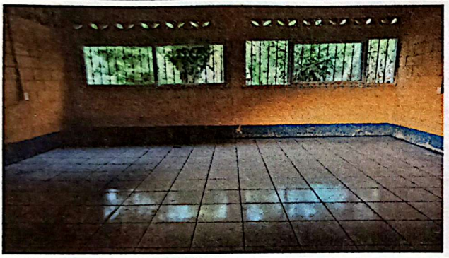
Foto #3: Sustitución de ventanas de metal por ventanas pvc. 25 ventanas, 74.3 m2
