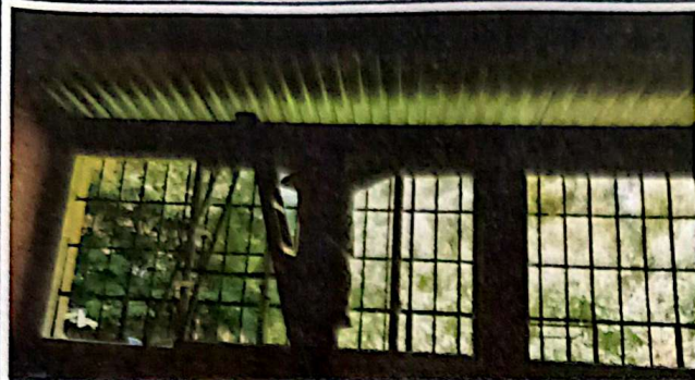
Foto #1: Sustitución de ventanas de metal por ventanas pvc. 25 ventanas, 74.3 m2
