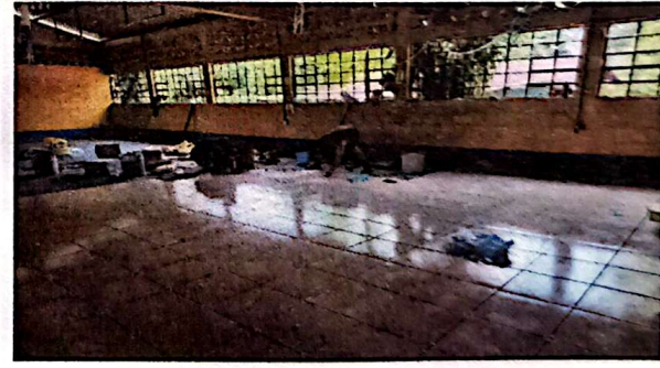
Foto #6: Sustitución de piso de concreto por piso cerámico. 9 aulas, 378 m2.
