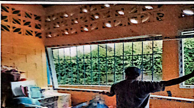
Foto #3: Sustitución de ventanas de metal por ventanas pvc. 25 ventanas, 74.3 m2.
