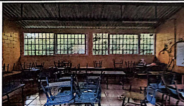
Foto #4: Sustitución de ventanas de metal por ventanas pvc. 25 ventanas, 74.3 m2
