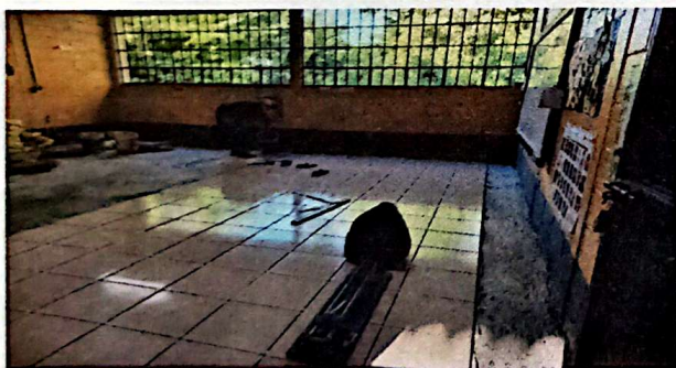
Foto #5: Sustitución de piso de concreto por piso cerámico. 9 aulas, 378 m2.
