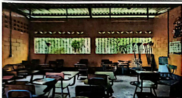
Foto #3: Sustitución de ventanas de metal por ventanas de pvc. 25 ventanas, 74.3 m2
