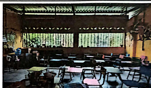
Foto #4: Sustitución de ventanas de metal por ventanas de pvc. 25 ventanas, 74.3 m2
