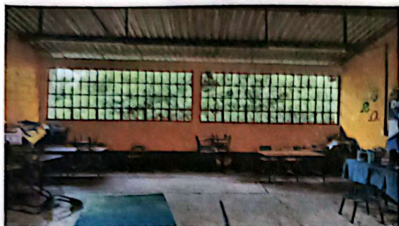
Foto #1: Sustitución de ventanas de metal por ventanas de pvc. 25 ventanas, 74.3 m2
