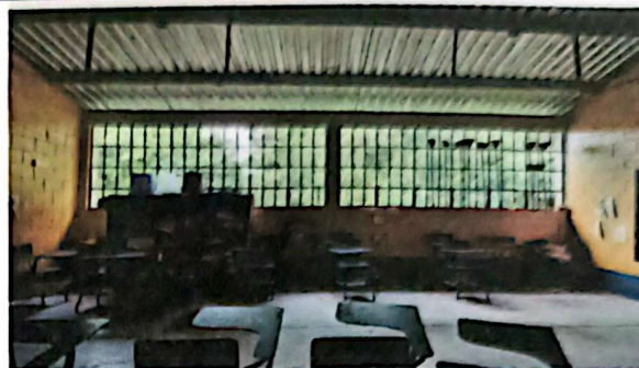
Foto #2: Sustitución de ventanas de metal por ventanas de pvc. 25 ventanas, 74.3 m2
