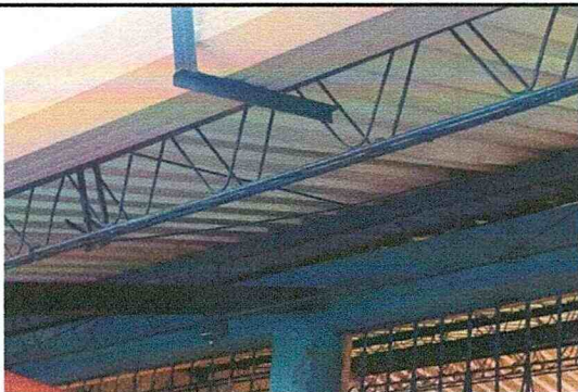
Foto 5: Mantenimiento a estructura de soporte de metal con anticorrosivo.
