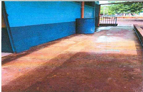
Foto 7: Reparación de 36 Metros lineales de bajadas de aguas pluiales con tubo PVC de 3 pulgadas en el módulo 1
