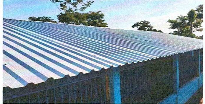
Foto 2: Sustitución de lámina, por lámina troquelada calibre 26.
