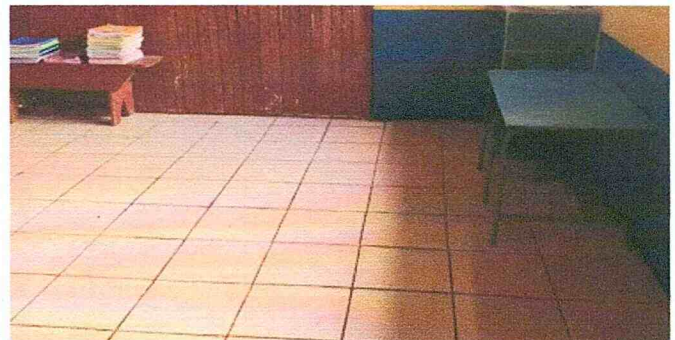
Foto 6: Sustitución de 320 M2 de piso alisado por piso cerámico en 6 aulas.
