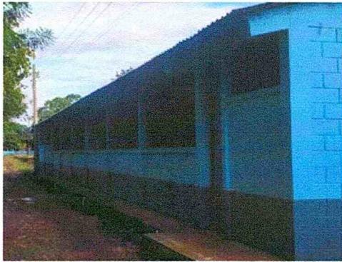
Foto1: Sustitución de lámina, por lámina troquelada calibre 26.
