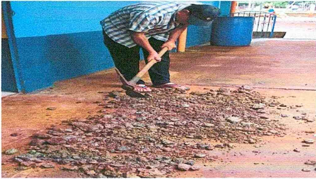
Foto 7: Reparación de 36 Metros lineales de bajadas de aguas pluviales con tubo PVC de 3 pulgadas en el módulo 1
