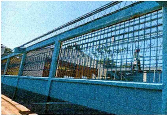
Foto1: Sustitución de lámina, por lámina troquelada calibre 26.
