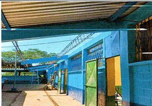
Foto 3: Mantenimiento a estructura de soporte de metal con anticorrosivo.
