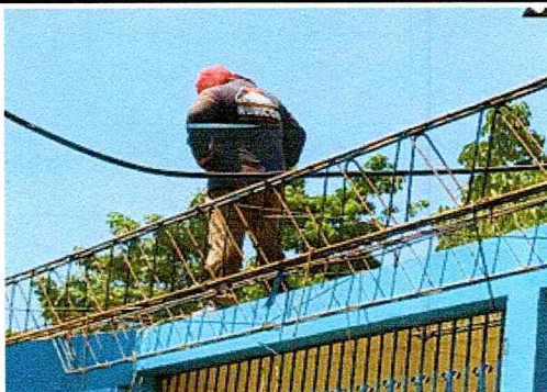
Foto 5: Mantenimiento a estructura de soporte de metal con anticorrosivo.
