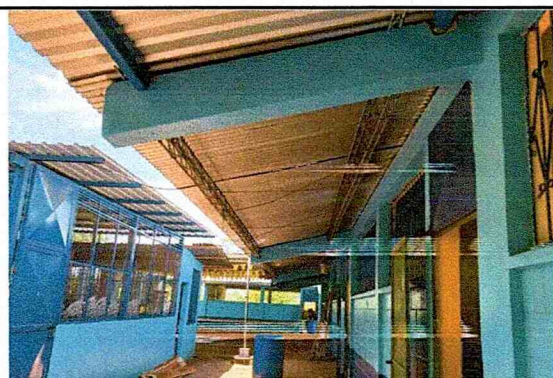
Foto 3: Mantenimiento a estructura de soporte de metal con anticorrosivo.
