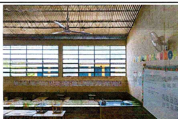
Foto 4: Mantenimiento a estructura de soporte de metal con anticorrosivo.
