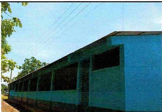
Foto 1: Sustitución de lámina, por lámina troquelada Calibre 26
