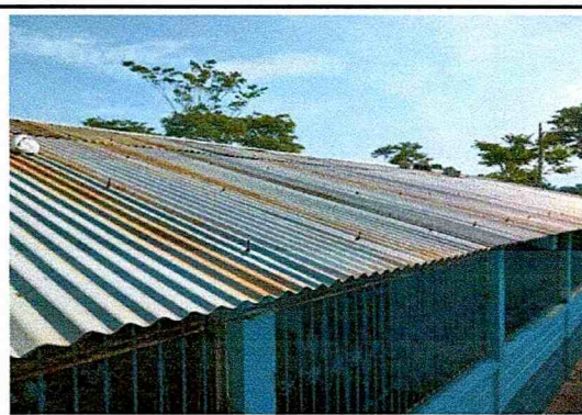
Foto 2: Sustitución de lámina, por lámina troquelada Calibre 26
