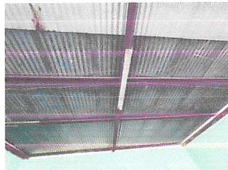
MANTENIMIENTO A ESTRUCTURA DE SOPORTE DE METAL ANTICORROSIVO
