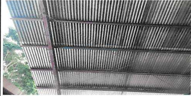
Sustitución de estructura de soporte de metal galvanizado
