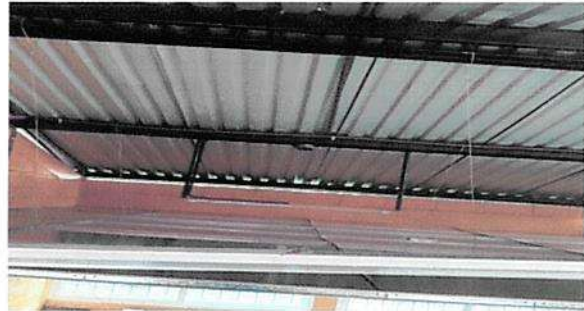
Suministro e Instalación de PVC cielo Falso
