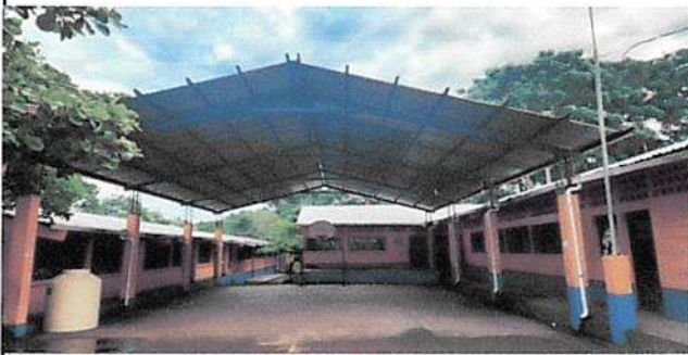
Sustitución de cubierta laminar por lamina troquelada C26
