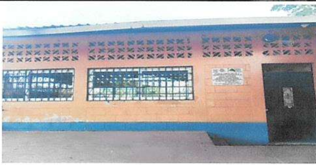
Suministro e Instalación de PVC cielo Falso
