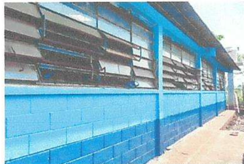
SUSTITUCIÓN DE 85 M2 DE VENTANAS POR BALCONES DE HIERRO DE 1/2 X 1/2 Y HIERRO PLANO DE 1/2 X 1/8
