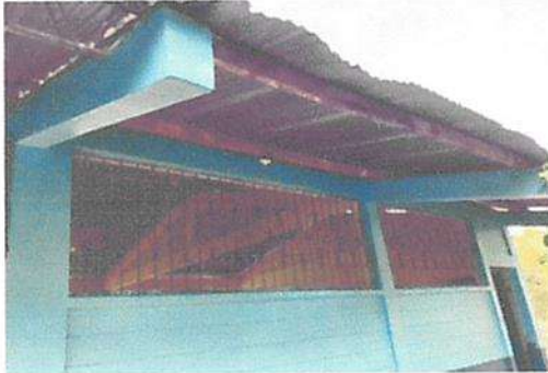
SUSTITUCIÓN DE 144 M2 DE LÁMINA, POR LÁMINA TROQUELADA CALIBRE "26"
