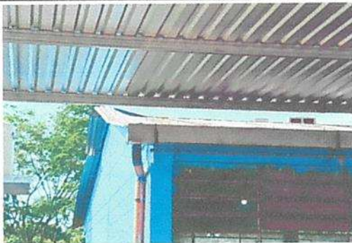
SUSTITUCIÓN DE 38 ML DE CAPOTE DE LÁMINA POR CAPOTE DE LÁMINA CALIBRE "26"
