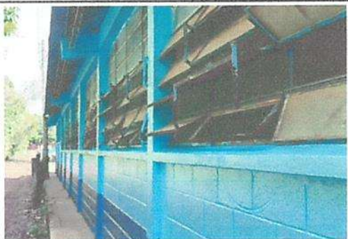
SUSTITUCIÓN DE 85 M2 DE VENTANAS POR BALCONES DE HIERRO DE 1/2 X 1/2 Y HIERRO PLANO DE 1/2 X 1/8
