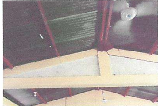
SUSTITUCIÓN DE ESTRUCTURA DE MADERA POR 20 COSTANERAS DE 4 X 2 X 1/16
