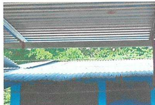
SUSTITUCIÓN DE 38 ML DE CAPOTE DE LÁMINA POR CAPOTE DE LÁMINA CALIBRE "26"
