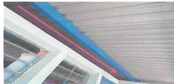
Reparación de malla en aulas entre pared y techo en 4 aulas para evitar que ingresen las palomas u otro animal a ellas
