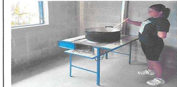
Sustitución de estufa en cocina con ladrillo y chimenea
