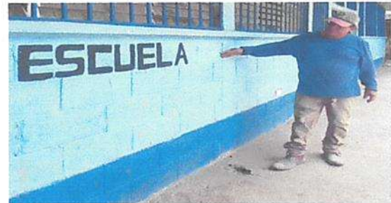
Suministro y aplicación de pintura en paredes de aulas
