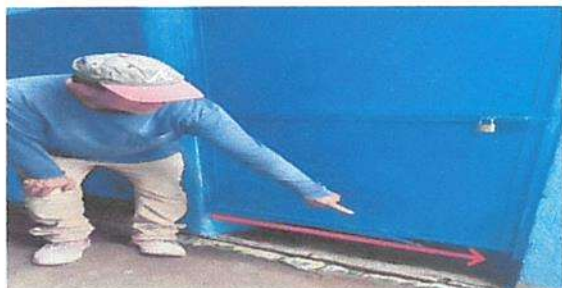
Reparación de puertas de 4 sanitarios
