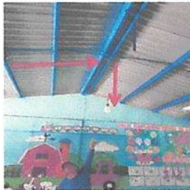
Sustitución de de energía eléctrica en 4 aulas incluye (4 lamparas, 4 tomacorrientes, 4 apagadores, cableado y poliducto)
