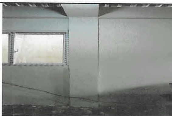
Reparacion de muro con columnas 0.20 x 0.20 x 4.0 M. Hierro de 1/2" y estribos 3/8". 8 unidades
