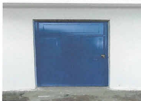
Sustitución de puerta de madera por puerta de metal. 1 Unidad. Medidas 1 x 2.05 con chapa Yale
