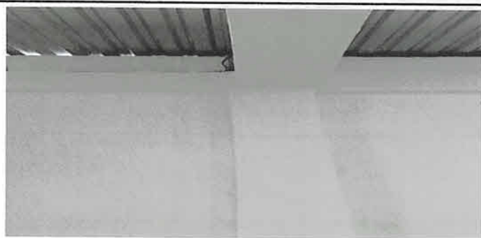
Reparación de muro con viga de 0.25 x 0.30 con varillas de 1/2 y estribos de 3/8". 28.2 m2
