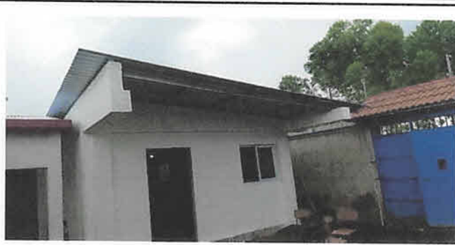
Sustitución de estructura portante de techo por estructura de metal 46 m2
