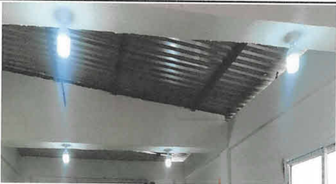
SUSTITUCION DE BOMBILLOS LED DE 40 WATTS, 6 UNIDADES
