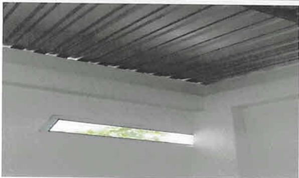
Sustitucioin de lamina acanalada por lamina troquelada 26.46 m2
