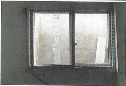
SUSTITUCION DE VENTANA DE MADERA POR VENTANA DE UPVC CORREDIZA 3 UNIDADES
