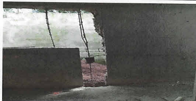
Reparacion de muro con columnas 0.20 x 0.20 x 4.0 M. Hierro de 1/2" y estribos 3/8". 8 unidades
