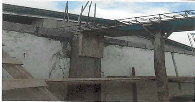
Reparación de muro con viga de 0.25 x 0.30 con varillas de 1/2 y estribos de 3/8". 28.2 m2
