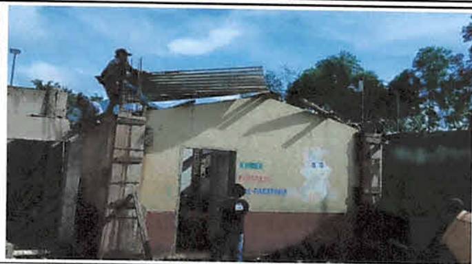
Sustitucioin de lamina acanalada por lamina troquelada 26.46 m2
