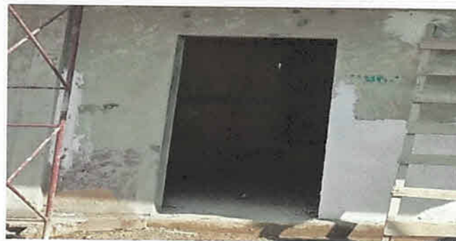
Sustitución de puerta de madera por puerta de metal. 1 Unidad. Medidas 1 x 2.05 con chapa Yale
