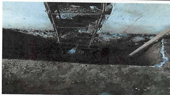
Reparación de muro con zapata 0.80 x 0.80x 0.20 M. Hierro de 1/2". 8 unidades
