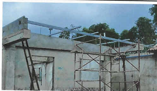
Sustitución de estructura portante de techo por estructura de metal 46 m2
