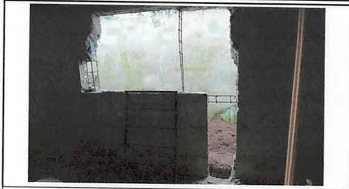
SUSTITUCION DE VENTANA DE MADERA POR VENTANA DE UPVC CORREDIZA 3 UNIDADES
