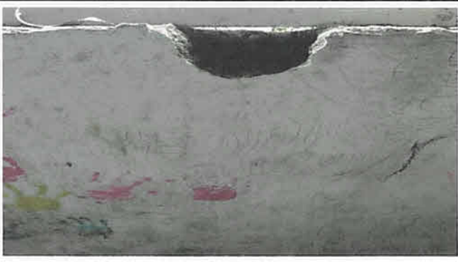
Reparación de muro con columnas 0.20x0.20x4.0m 4 Hierro 1/2" y estribos 3/8". 8 unidades
