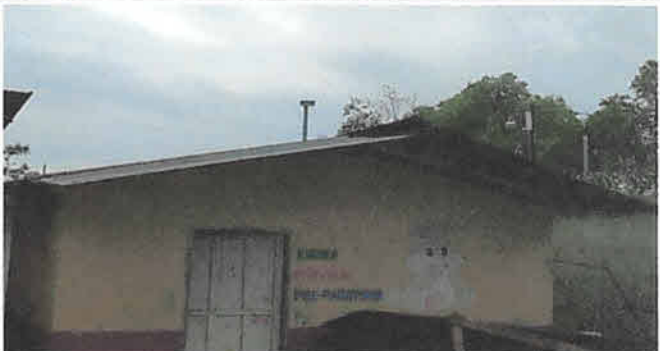
Sustitucion de estructura de madera portante de techo por estructura de metal. 46 m2
