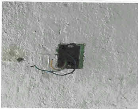
Reparación de sistema eléctrico cableado calibre 10 AWG, Sustitución apagadores dobles, 3 unidades y Sustitución tomacorrientes dobles, 6 unidades
