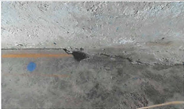
Reparación de muro con zapata 0.80x0.80x0.20M Hierro 1/2". 8 unidades
