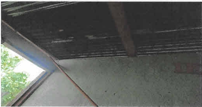
Sustitucion de lamina acanalada por lamina troquelada calibre 26. 46 m2
