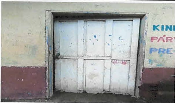
Sustitución de puerta de madera por puerta de metal. 1 unidad
