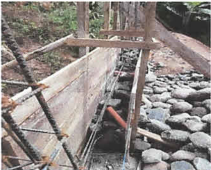
Reparación de muro de contención MC2-H=3.00 y losa de cimentación. 80M3 (Losa de cimentación: 27mx1.4mx1.25m=47.10m3 + Muro de Contención: 27mx2.6mx0.47m= 32.9m3)
