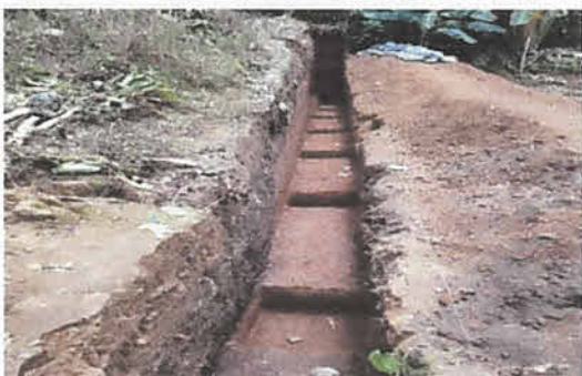
Reparación de muro de contención MC2-H=3.00 y losa de cimentación. 80M3 (Losa de cimentación: 27mx1.4mx1.25m=47.10m3 + Muro de Contención: 27mx2.6mx0.47m= 32.9m3)
