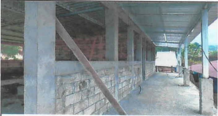
Reparación 32 M2 de muro con columnas 0.20m x 0.20m 4 hierro de 3/8 estribos de 1/4
