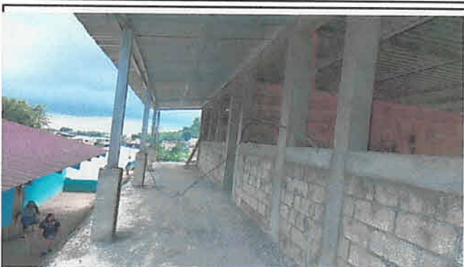
Reparación 32 M2 de muro con columnas 0.20m x 0.20m 4 hierro de 3/8 estribos de 1/4
