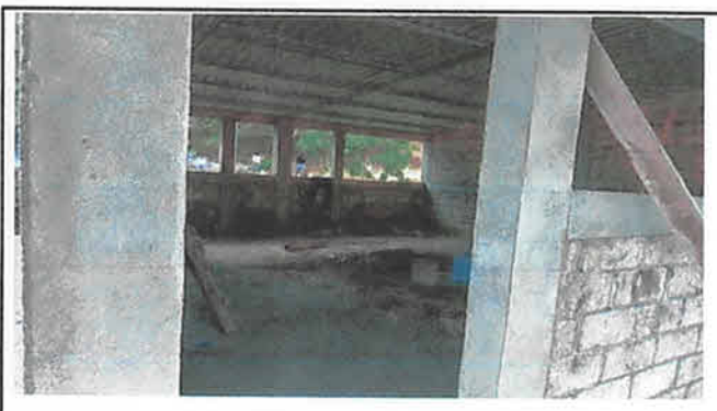
Sustitución 135 M2 de estructura de soporte por metal y lámina troquelada calibre 26.
