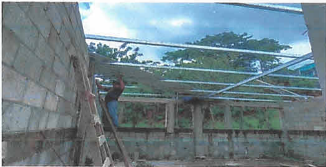
Sustitución 135M2 de estructura de soporte por metal y lámina troquelada calibre 26.
