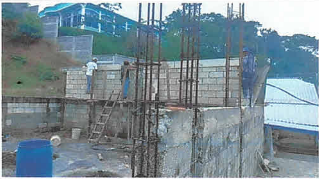
Reparación 32 M2 de muro con columnas 0.20m x 0.20m 4 hierro de 3/8 estribos de 1/4
