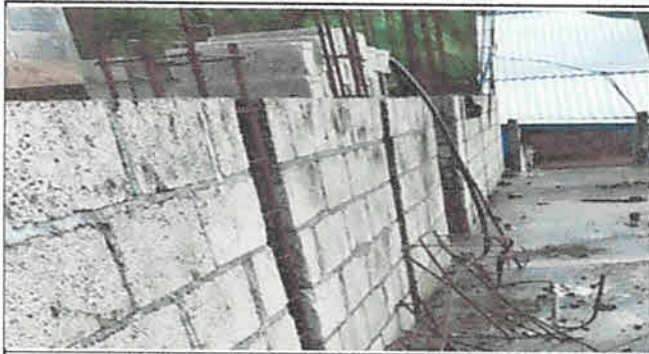
reparacion de muro con columnas 0.20m x 0.20m 4 hierro de 3/8 estribos de 1/4 30 mt2
