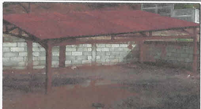
Sustitucion de estructura de soporte por metal y lamina troquelada calibre 26 135 mts2
