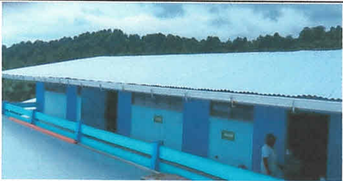
Suministro e instalación de láminas acanaladas calibre 26 para tres aulas del módulo 3 y de los baños, 418 mts2
