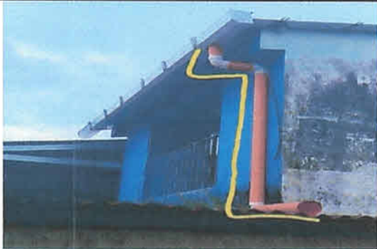
Instalación de bajada de agua pluvial en el módulo 3, 6 ml
