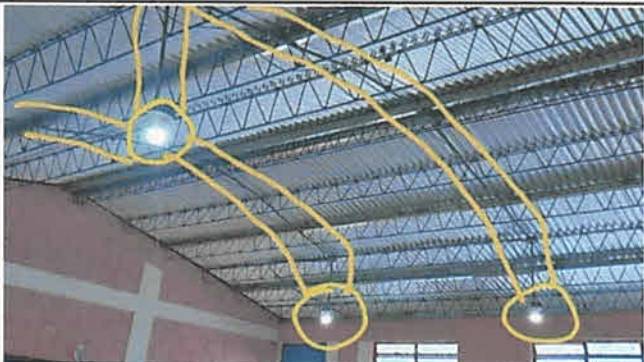
Suministro e instalación de red eléctrica de tres aulas del módulo 3 y de los baños, 200 ml
