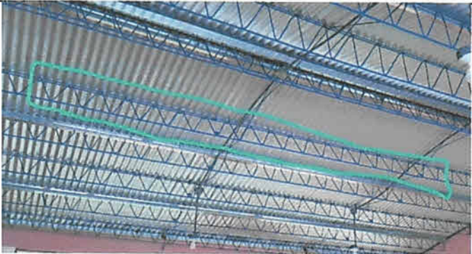
Mantenimiento de viga tipo Joist de tres aulas del módulo 3; 475 mts2
