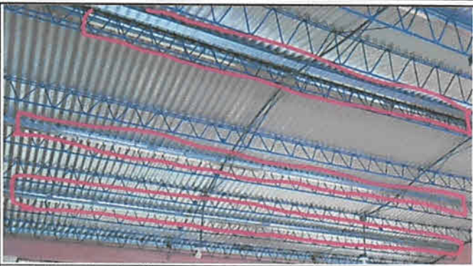
Suministro e instalación de estructura de soporte de metal de tres aulas del módulo 3 y de los baños, 342 mts2
