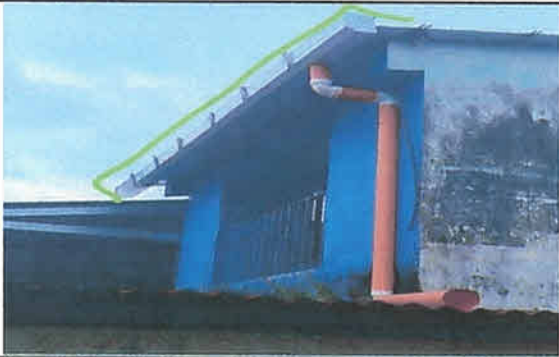
Suministro e instalación de canal pluvial de metal en el módulo 3; 6 ml
