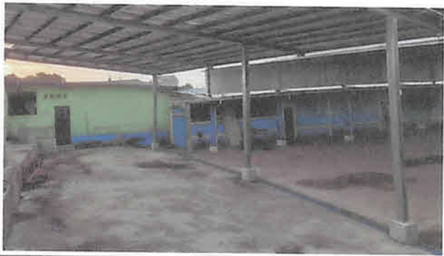
Sustitución de lámina, por lámina troquelada Calibre 26 en área de ingreso m2
