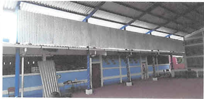
Sustitución de laminas por laminass acanaladas calibre 26 en área de salón.
