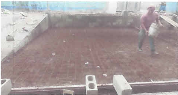
Sustitución de piso de torta de concreto en área de ingreso m2
