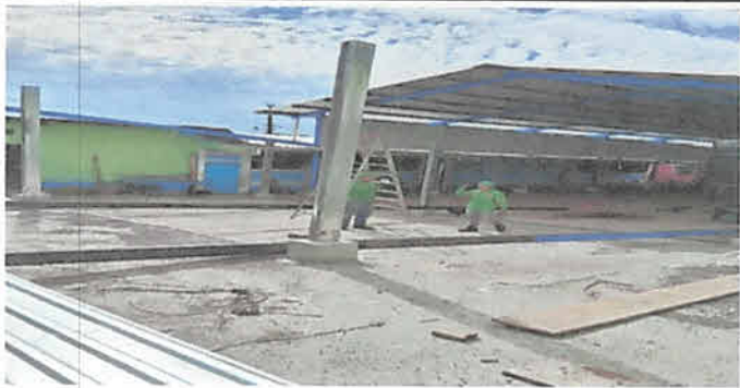
Sustitución de estructura de soporte (madera o metal) por metal en área de ingreso m2
