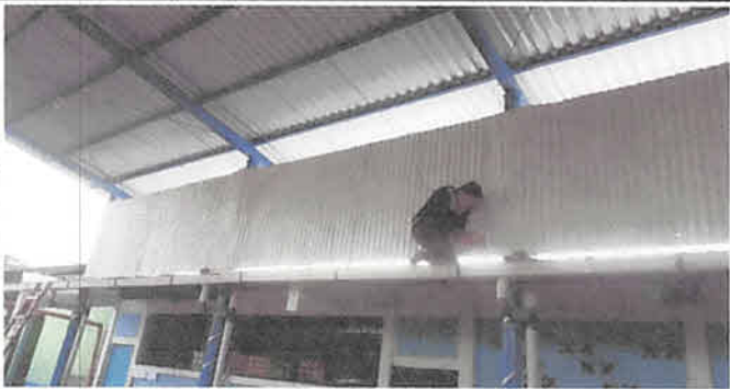
Sustitución de laminas por laminass acanaladas calibre 26 en área de salón.
