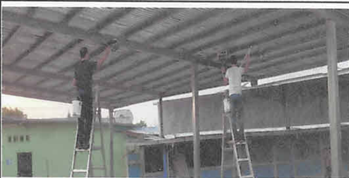
Sustitución de lámina, por lámina troquelada Calibre 26 en área de ingreso m2
