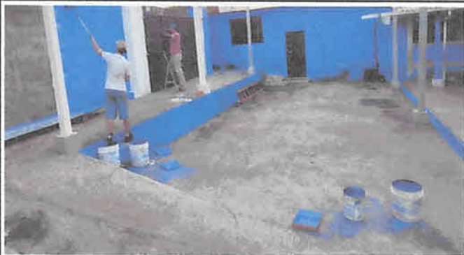
Suministro y aplicación Pintura exterior látex celeste Pantone 293 para muros en área de ingreso m2
