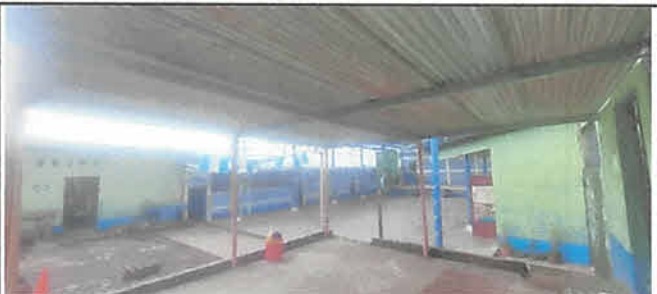
Sustitución de lámina, por lámina troquelada Calibre 26 en área de ingreso m2
