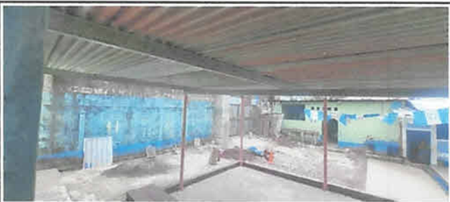
Suministro y aplicación Pintura exterior látex celeste Pantone 293 para muros en área de ingreso m2
