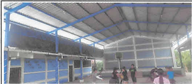
Sustitución de laminas por laminass acanaladas calibre 26 en área de salón.
