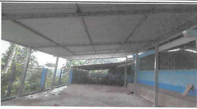
Sustitución de lámina troquelada calibre 26, atrás módulo 1 155 m2
