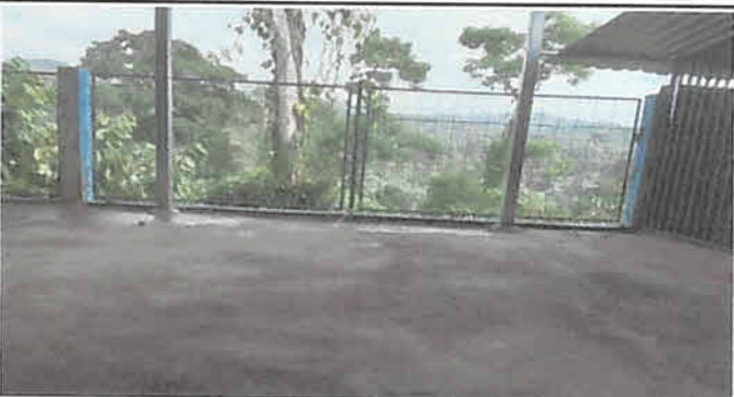
Sustitución piso de concreto en patio 155 m2
