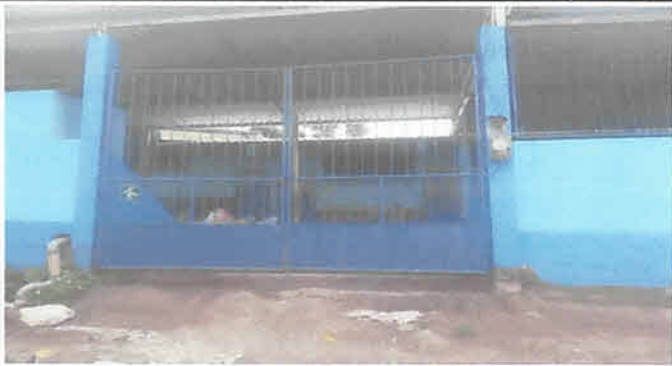
Reparación de Portón, lijado y pintado 1 unidad
