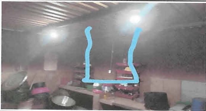
Sustitución de cableado eléctrico calibre 12 AWG en cocina. 50 ml
