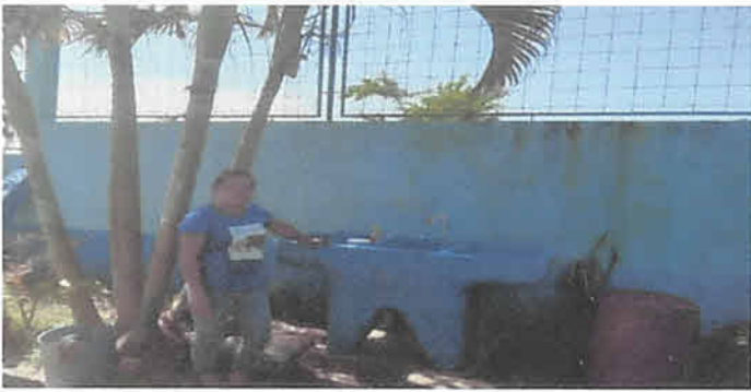
Sustitución de pilas de concreto a pilas de plastico 2 unidades
