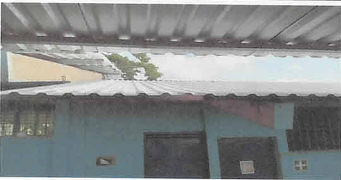
Sustitución lámina troquelada calibre 26 entre módulos 16 m2
