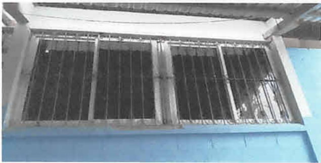
Sustitución de ventanas de lámina a ventanas de pvc 2 unidad
