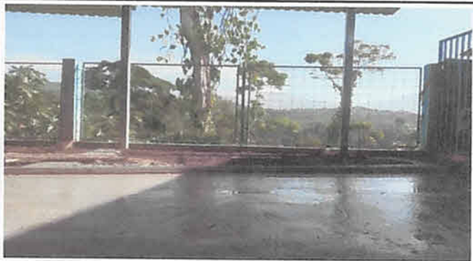
Sustitución piso de concreto en patio 155 m2
