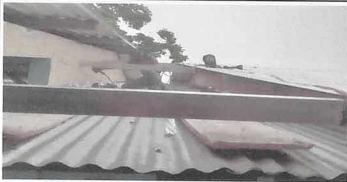
Foto 3: sustitución de lámina entre módulos
