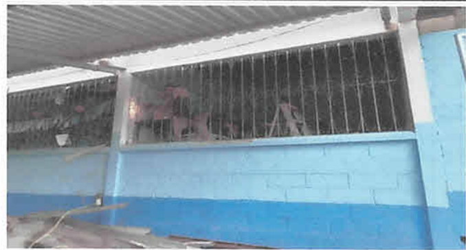
Sustitución de ventanas de lámina a ventanas de pvc 2 unidad
