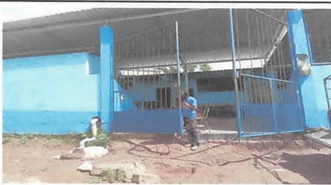
Reparación de Portón, lijado y pintado 1 unidad
