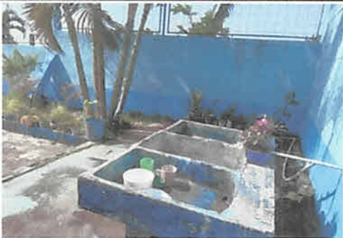
Sustitución de pilas de concreto a pilas de plastico 2 unidades
