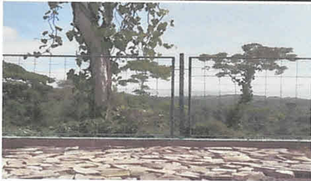
Sustitución piso de concreto en patio 155 m2
