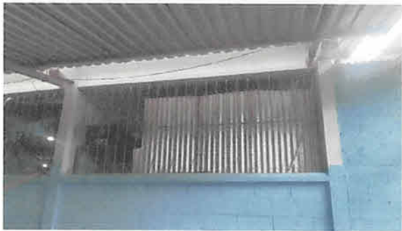
Sustitución de ventanas de lámina a ventanas de pvc 2 unidad
