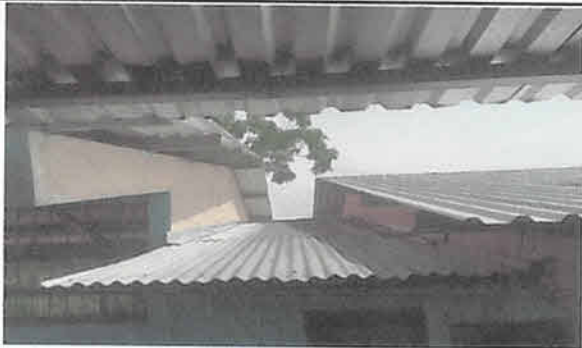
Sustitución lámina troquelada calibre 26 entre módulos 16 m2
