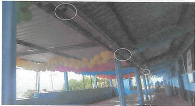
Sustitución bajada de agua pluvial, tubo PVC 3" (accesorios) mas abrazadera
