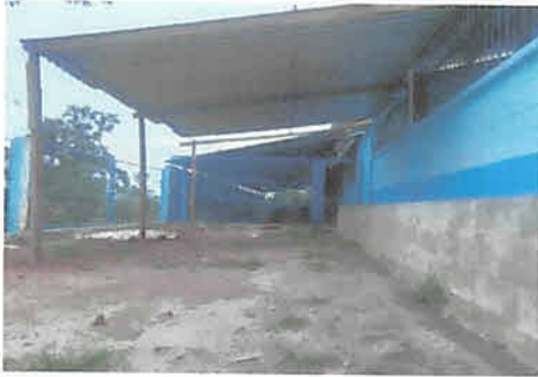
Sustitución de lámina troquelada calibre 26, atrás módulo 1 155 m2
