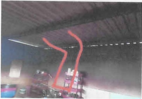
Sustitución de cableado eléctrico calibre 12 AWG en cocina. 50 ml
