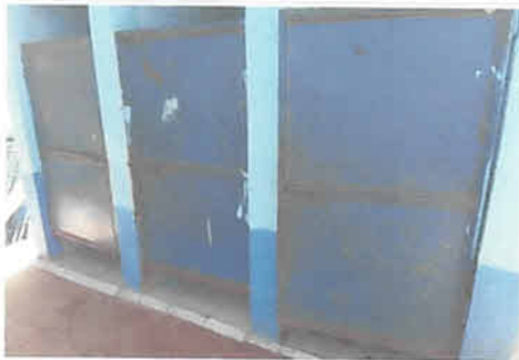
Sustitución puerta sevicios sanitarios 3 unidades
