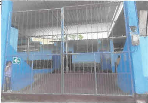
Reparación de Portón, lijado y pintado 1 unidad
