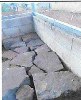
Sustitución de piso de cocina
