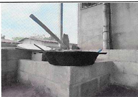
Sustitución de estufa de cocina
