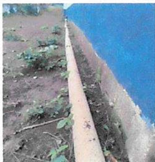
Sustitución tubería drenaje
