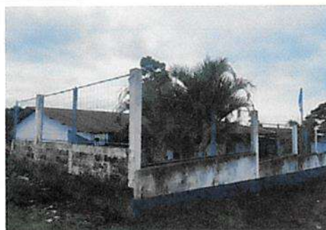
Suministro y aplicación de pintura de muro perimetral
