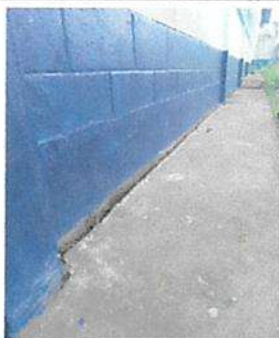
Sustitución de torta de concreto ( banqueta)
