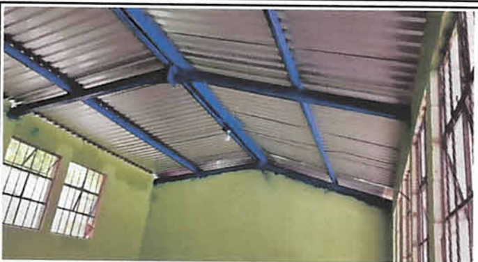
Foto 2: Sustitución de estructura de soporte madera por metal en módulo 1 83 mts2
