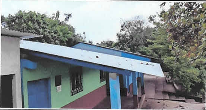
Foto 1. Sustitución de lámina por lámina troquelada calibre 26 en cocina 83 mts2
