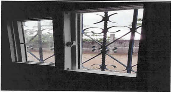
Foto 3: Sustitución de ventanas tipo UPV-C en cocina 2 mts2
