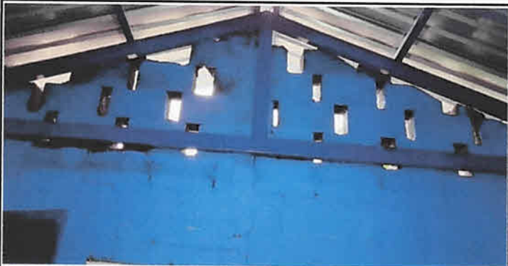
Foto 9: Suministro y aplicación pintura en cocina 108 mts2
