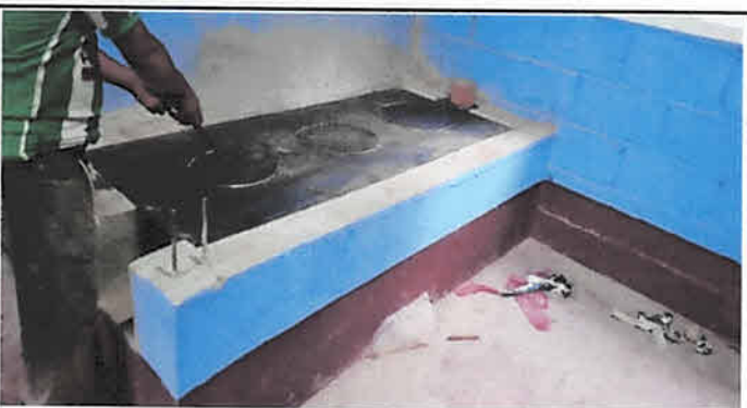
Foto 4: Sustitución de estufa y chimenea en cocina
