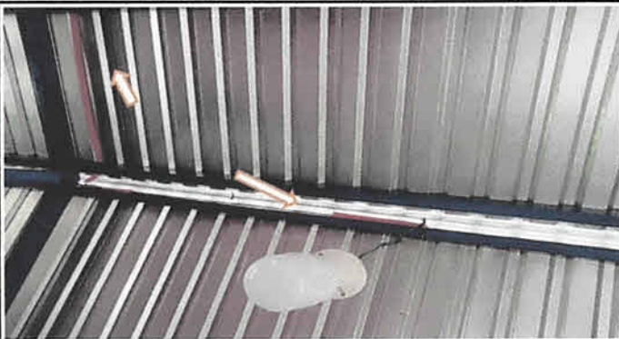
Foto 16: Mantenimiento de cableado eléctrico calibre 12 awg en cocina 40 mtsL.
