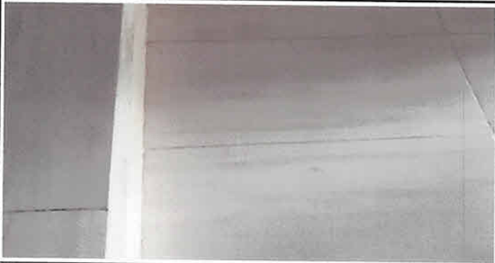
Foto 7: Sustitución de azulejo en cocina 6 mts2
