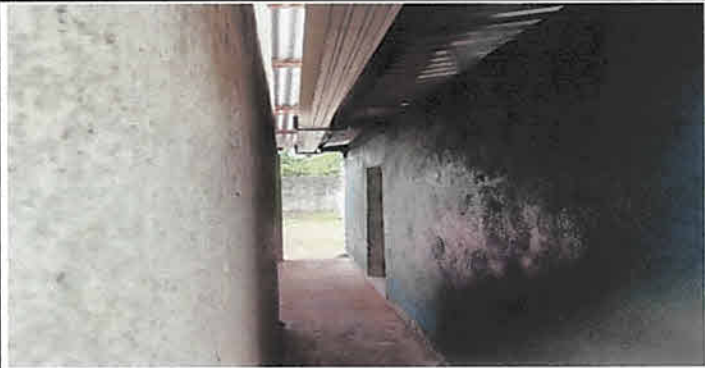
Foto 13: Repello en muros en cocina 65 mts2
