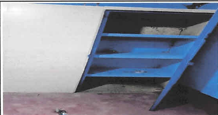
Foto 15: Sustitución de muebles de madera por material fundido in situ
