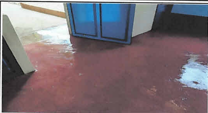
Foto 8: Sustitución de piso de cemento en cocina + aplicación de color 22 mts2
