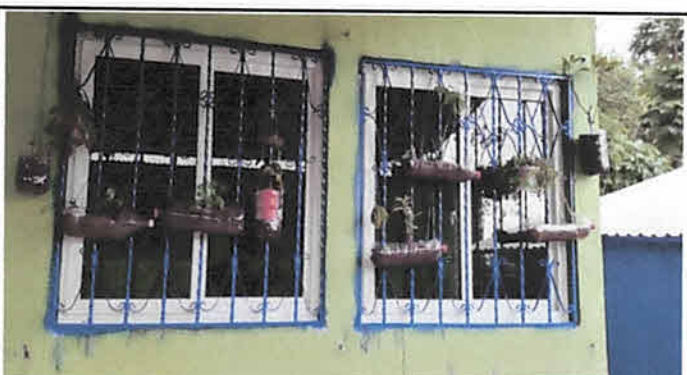
Foto 10: Sustitución de balcón en cocina 2 mts2
