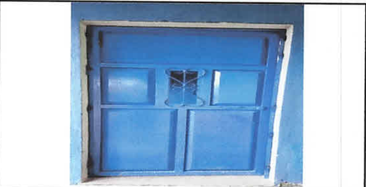
Foto 11: Sustitución de puerta de metal en cocina
