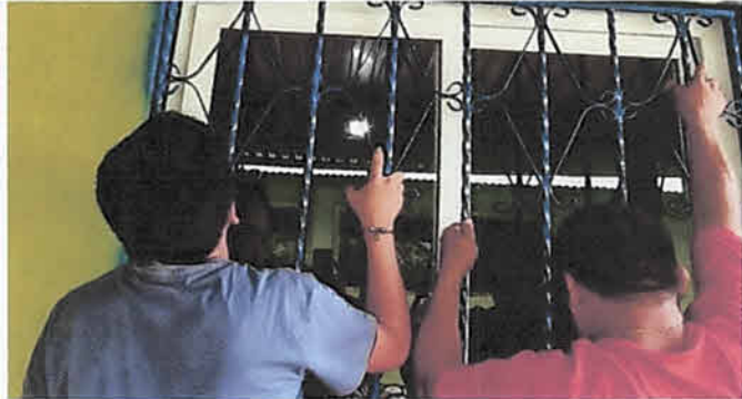
Foto 10: Sustitución de balcón en cocina 2 m²
