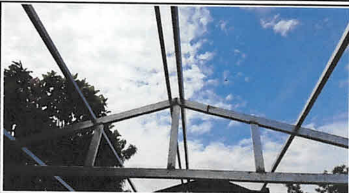
Foto 2: Sustitución de estructura de soporte madera por metal en módulo 1, 83 m²
