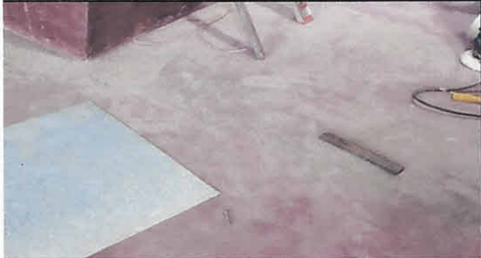
Foto 8: Sustitución de piso de cemento en cocina + aplicación de color 22 m²
