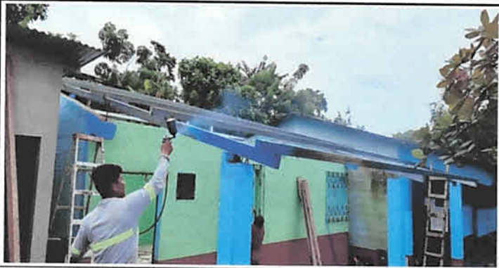
Foto1: Sustitución de lámina por lámina troquelada calibre 26 en cocina 83 m²
