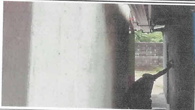
Foto13: Repello en muros en cocina 65 m²
