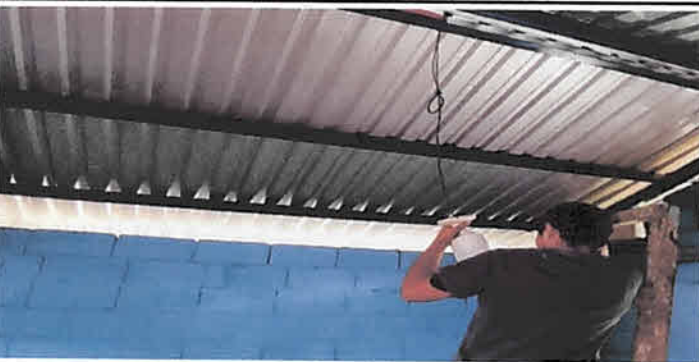
Foto 5: Sustitución de lampara existente con lamparas bombillos led globo 30 watts , para pasillo, 2400 lumenes
