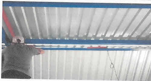
Foto 16: Mantenimiento de cableado eléctrico calibre 12 awg en cocina
