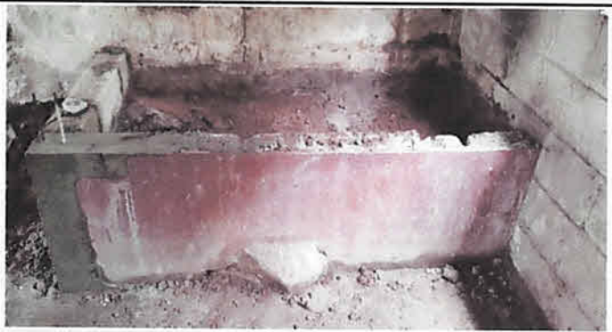
Foto 4: Sustitución de estufa y chimenea en cocina
