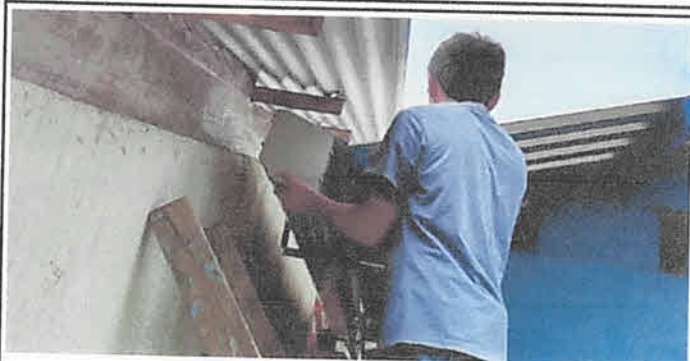
Foto 14: Sustitución de canal de metal en cocina 8mtsL.
