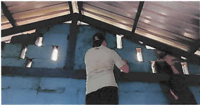
Foto 9: Suministro y aplicación pintura en cocina 108 m²
