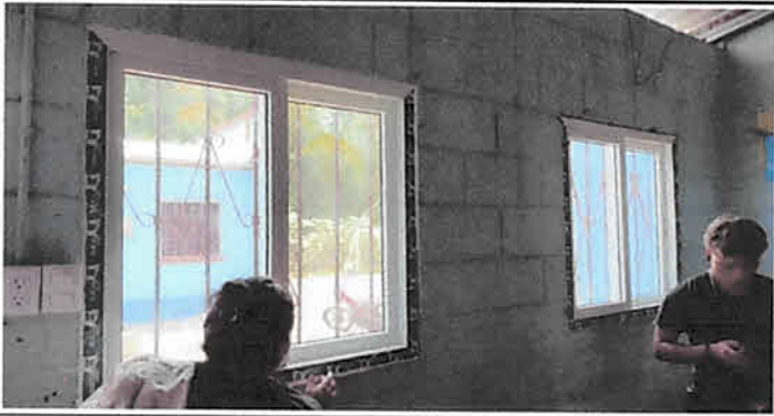
Foto 3: Sustitución de ventanas tipo UPV-C en cocina 2 m²
