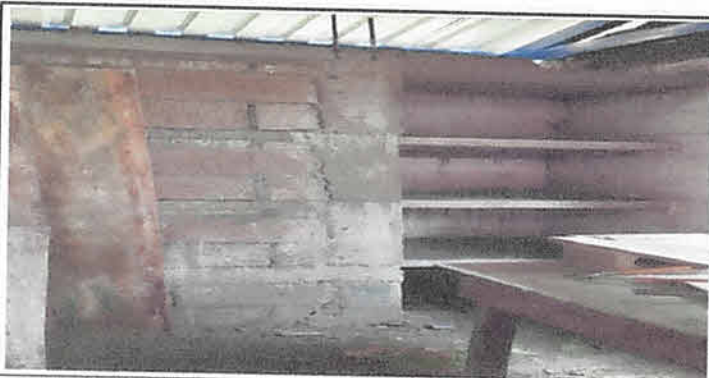
Foto 15: Sustitución de muebles de madera por material fundido en situ
