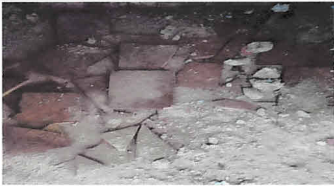
Foto 7: Sustitución de azulejo en cocina 6 m²
