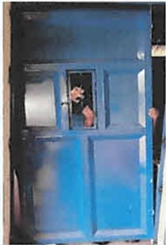
Foto 11: Sustitución de puerta de metal en cocina
