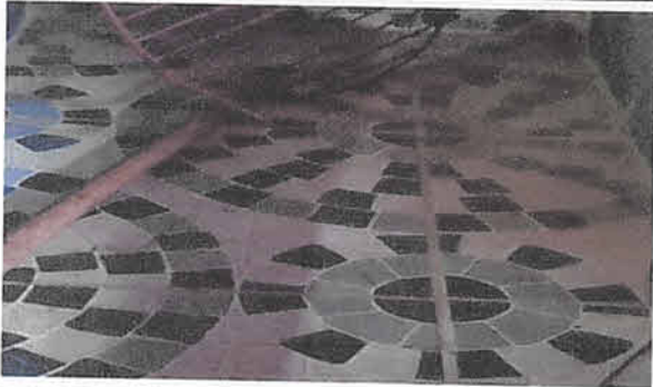
Sustitución de azulejo en cocina 6 mts2
