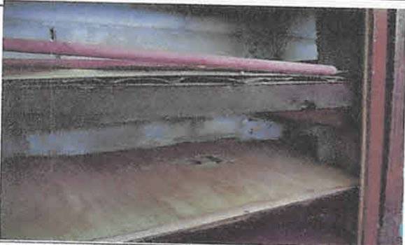
Sustitución de muebles fijos de madera por material fundido in situ
