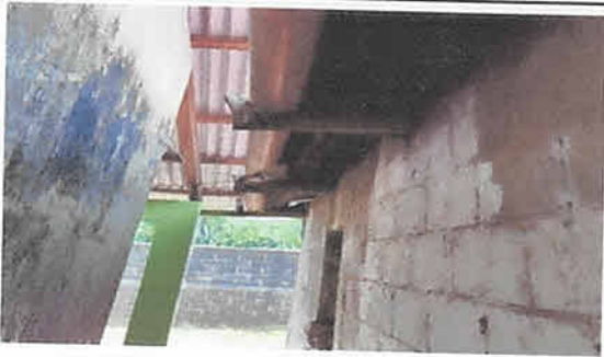
Repello en muros en cocina 65 mts2
