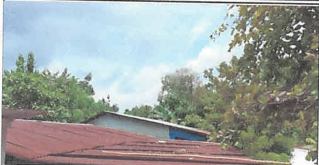
Sustitución de lámina por lámina troquelada calibre 26 en cocina 83 mts2
