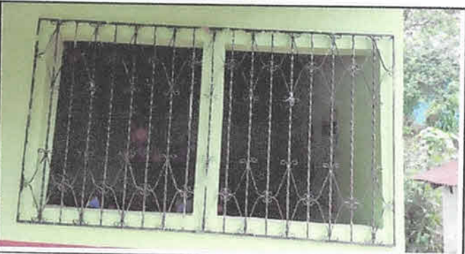
Sustitución de balcón en cocina 2 mts2
