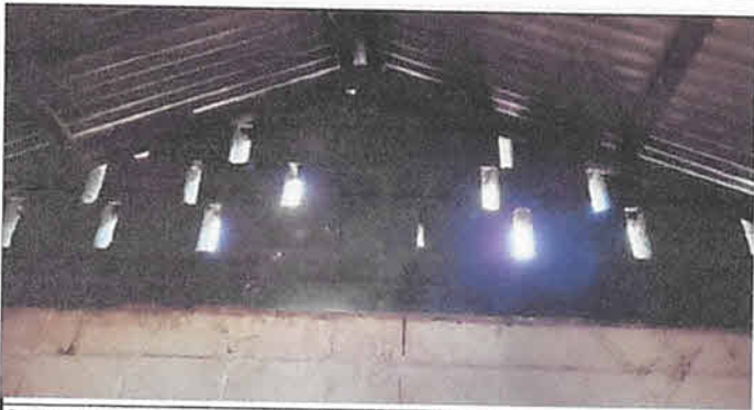
Suministro y aplicación pintura en cocina 108 mts2
