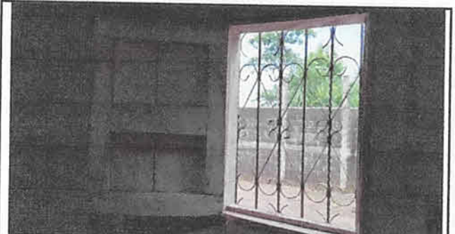
Sustitución de ventanas tipo UPV-C en cocina 2 mts2
