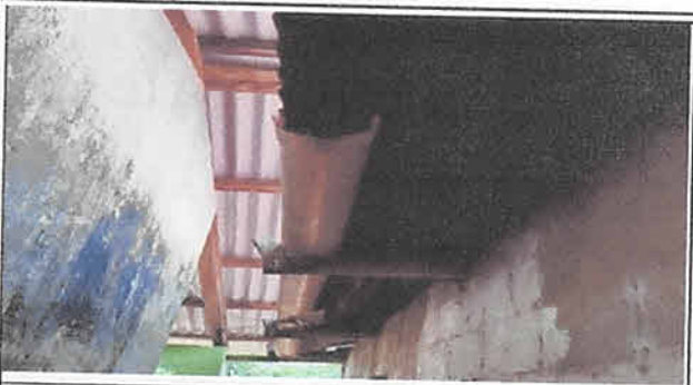
Sustitución de canal de metal en cocina 8 mtsL.
