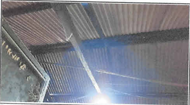
Reparación de cableado eléctrico calibre 12 awg en cocina 40 mtsL.
