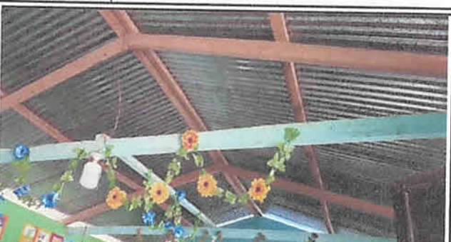
Sustitución de estructura de soporte madera por metal en módulo 1 83 mts2
