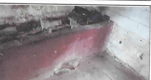
Sustitucion de estufa en cocina con ladrillo y chimenea
