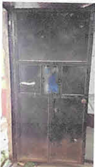
Sustitución de puerta de metal de 1.00* 2.10 m en cocina
