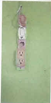
Sustitucion de tomacorrientes en cocina
