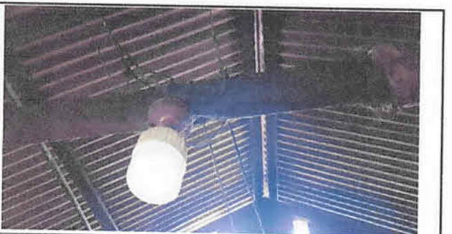
Sustitución de lampara existente con lamparas bombillos led globo 30 watts, para pasillo, 2400 lumenes
