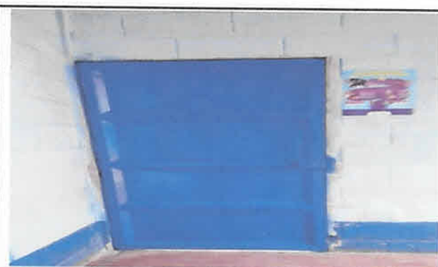
Sustitucion de puerta de 2.00 m * 1.00 m+ resanado de marco
