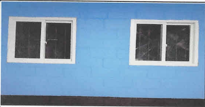
sustitucion de ventanas tipo U-PVC
