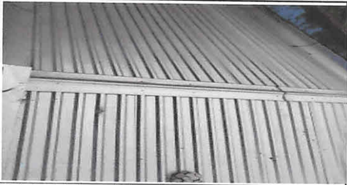
sustitucion de lamina por lamina calibre 26 44 mts2
