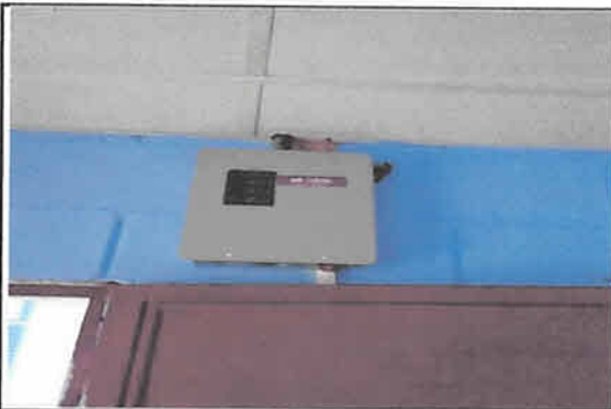
sustitucion de tablero pricipal 4 x 110
