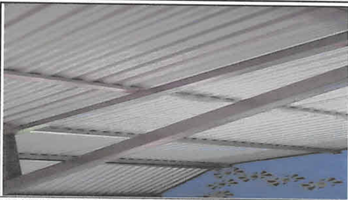
sustitucion de estructura de soporte 44 mts2
