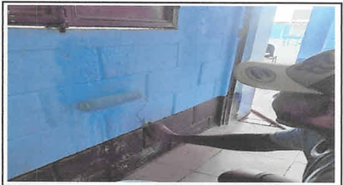
suministro y aplicación de pintura interior latex lavable 60 mts2
