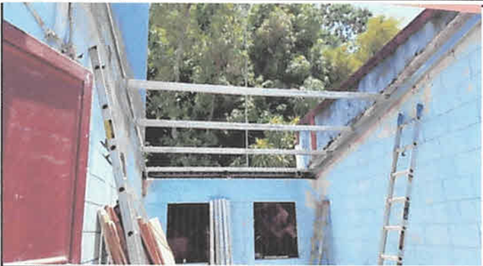
sustitucion de estructura de soporte 44 mts2
