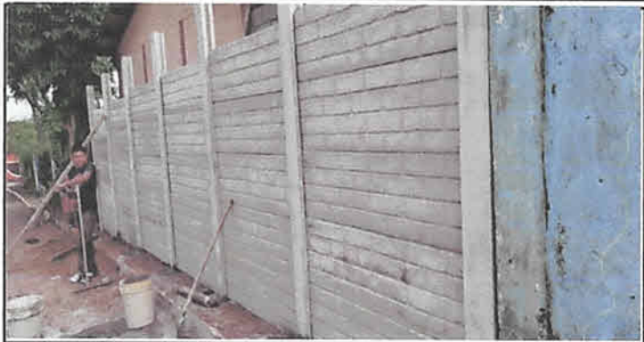
sustitucion de muro perimetral con barda prefabricada de concreto h=2.50m 37 mts2
