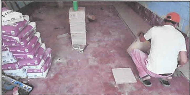
sustitucion de piso ceramico 34 mts2
