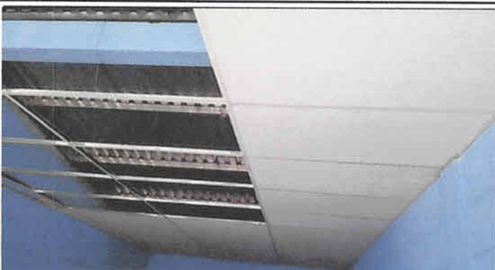
reparacion de cubierta con cielo falso 35 mts2
