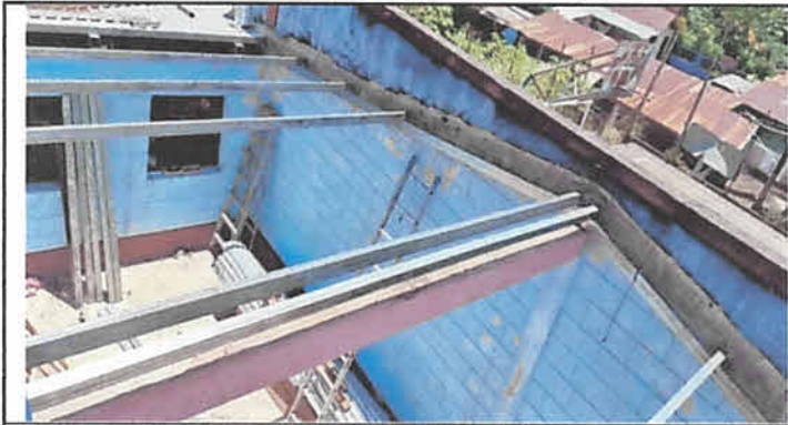
sustitucion de lamina por lamina calibre 26 44 mts2
