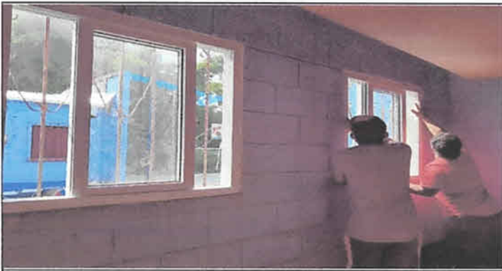
sustitucion de ventanas tipo U-PVC
