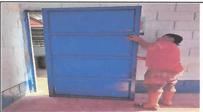
Sustitucion de puerta de 2.00 m * 1.00 m+ resanado de marco
