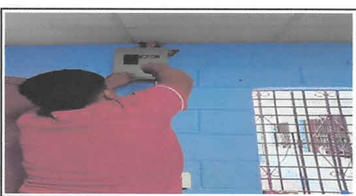
sustitucion de tablero pricipal 4 x 110
