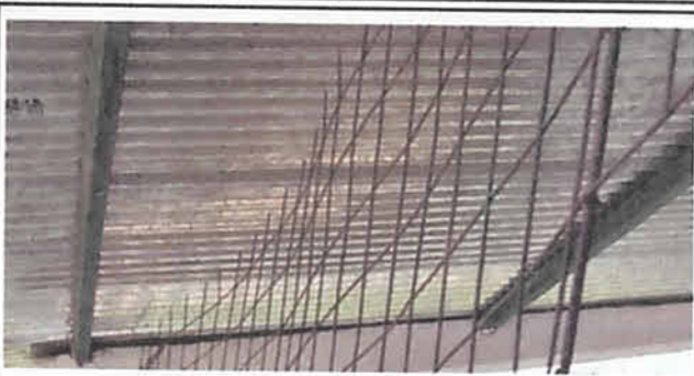
sustitucion de estructura de soporte 44 mts2
