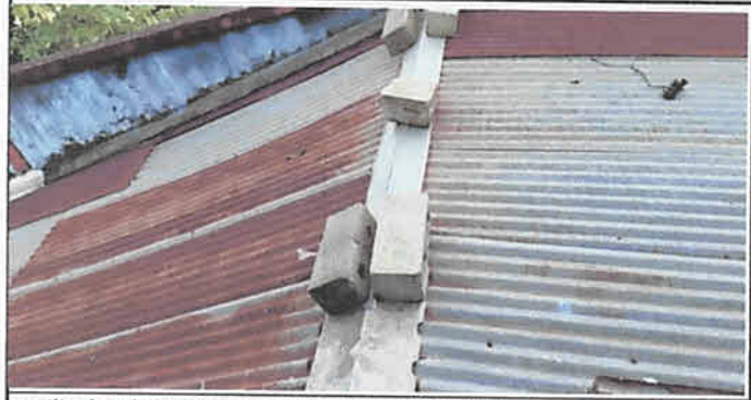
sustitucion de lamina por lamina calibre 26 44 mts2
