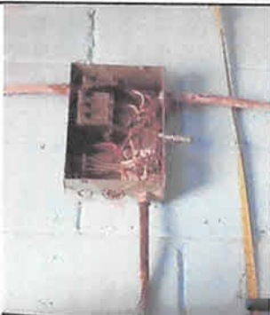
sustitucion de tablero principal 4 x 110
