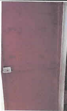
Sustitucion de puerta de 2.00 m * 1.00 m+ resanado de marco
