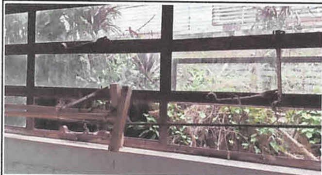
sustitucion de ventanas tipo U-PVC
