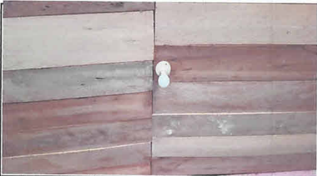
sustitucion de bombillo LED GLOBO 30w 2400 lumenes
