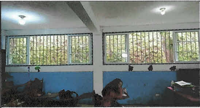
Mantenimiento correctivo en ventanas por ventanas tipo U-PVC. 37mts2.
