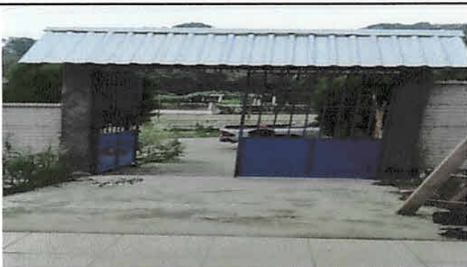
Sustitución de porton metálico 2.30*2.50 m con dos hojas, pasadores y chapa
