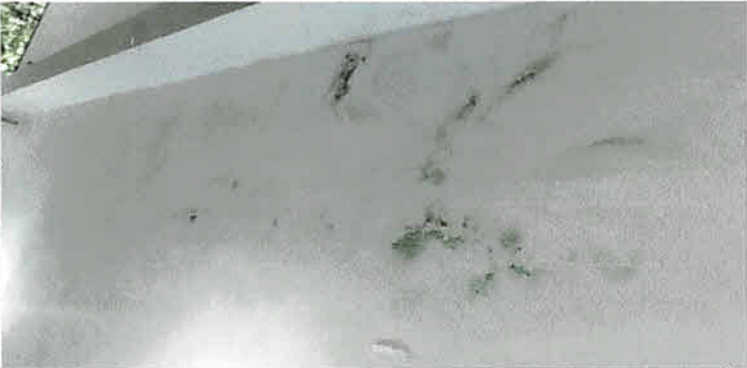
Impermeabilización de losa con impermeabilizante acrílico 6 años. 25mts2.
