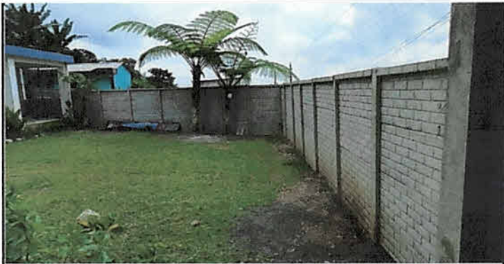
Sustitución de muro perimetral con barda prefabricada de concreto h=2.00m. 58mts2.
