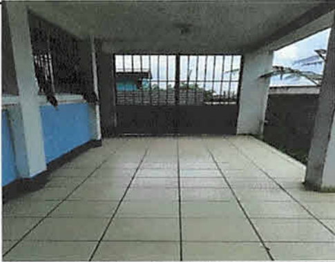
Susitución de porton metálico no. 2 : 1.80 * 2.58 m con dos hojas pasadores y chapa
