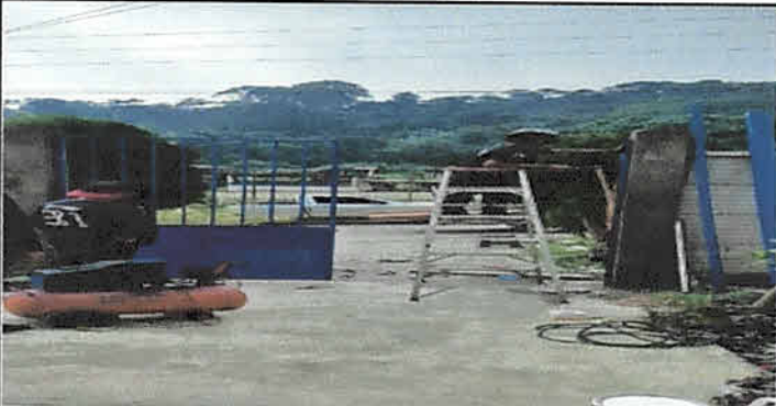
Sustitución de porton metálico 2.30*2.50 m con dos hojas, pasadores y chapa
