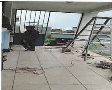
Susitución de porton metálico no. 2 : 1.80 * 2.58 m con dos hojas pasadores y chapa
