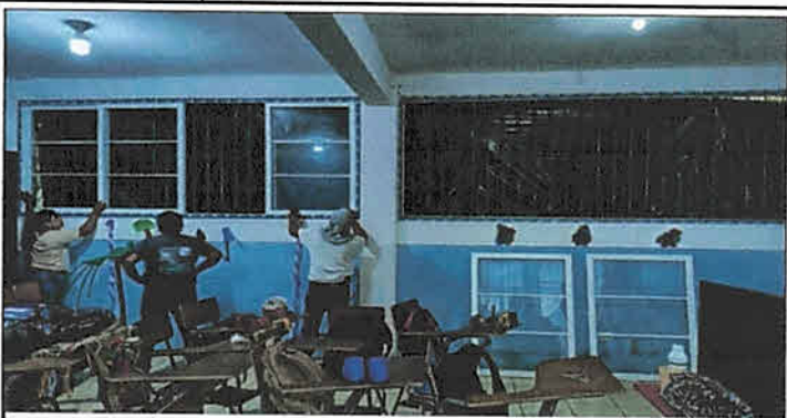
Mantenimiento correctivo en ventanas por ventanas tipo U-PVC. 37 mts2.
