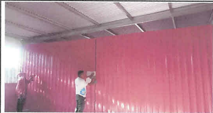
Foto1:Sustitución de muro divisorio de aula en módulo 4
