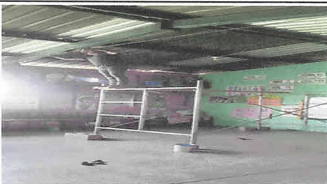
Foto 4: Sustitución de lámina troquelada por lámina troquelada calibre 26 en módulo 1, 2 y 3
