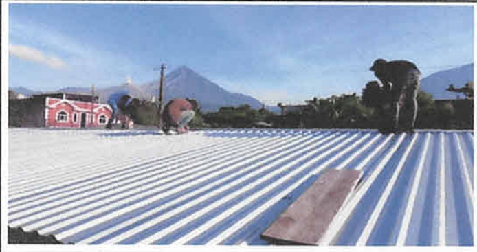
Foto 3: Sustitución de lámina troquelada por lámina troquelada calibre 26 en módulo 1, 2 y 3
