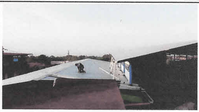
Foto 2: Sustitución de lámina troquelada por lámina troquelada calibre 26 en módulo 1, 2 y 3
