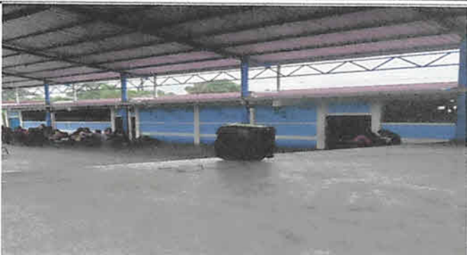
SUSTITUCION DE LÁMINA TROQUELADA POR LÁMINA TROQUELADA CALIBRE 26 EN MÓDULO 1 2 Y 3 487 MTS2
