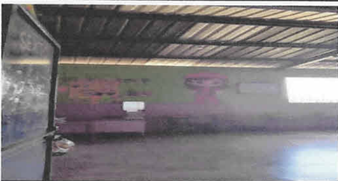
SUSTITUCIÓN DE LÁMINA TROQUELADA POR LÁMINA TROQUELADA CALIBRE 26 N MÓDULO 1 2 Y 3 487 MTS2
