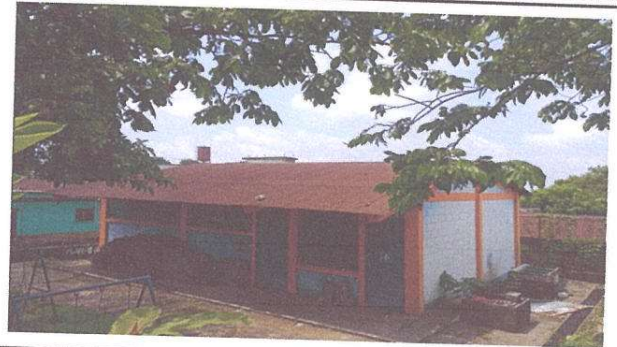
Sustitución de lamina acanalada por troquelada
