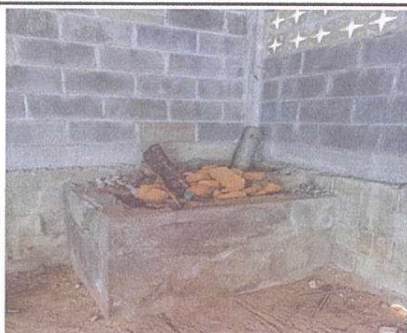
Sustitución de estufa de leña con chimenea
