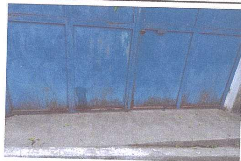
Reparación de portón metalico
