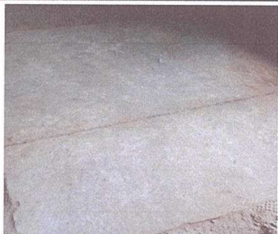
Sustitución de piso de concreto a piso ceramico en cocina
