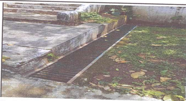
Mantenimiento de rejillas de cuneta
