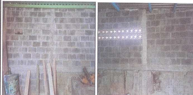
Repello y cernido de paredes con cretucco en cocina
