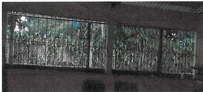
Sustitución de ventanas
