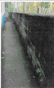
Reparación de muro perimetral existente de block de 0.40 x 20 m2
