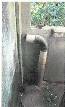
Sustitución de tubería PVC línea principal aguas pluviales 4", Sustitución de tubería PVC 1/2" línea principal
