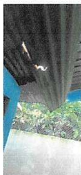
Sustitución de lámina acanalada Calibre 24, Sustitución de portante de madera por metal
