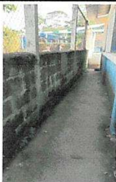
Reparación de muro perimetral existente de block de 0.40 x 20 m2
