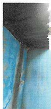
Sustitución de lámina acanalada Calibre 24, Sustitución de portante de madera por metal
