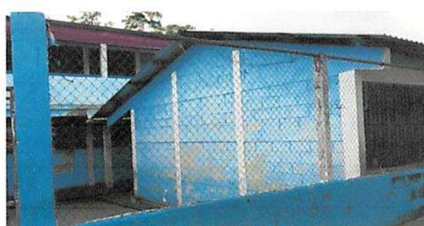
Sustitución de muro perimetral
