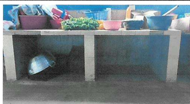
Sustitución de puertas en mesa de trabajo de cocina
