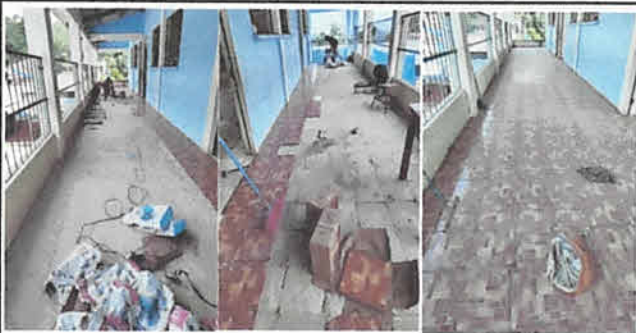
Sustitución de piso cerámico en el corredor del segundo nivel (56 m2)
