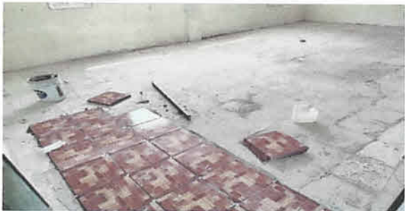
Sustitución de piso cerámico en tres aulas del segundo nivel (56 m2)
