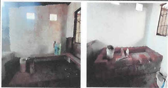
Sustitución de estufa rural por poyeton de ladrillo tayuyo con baldosa de 2.70m largo por 1m ancho x 0.60m alto, con tres fuegos con parrillas de hierro inoxidable de 1/2" desmontable, cada una con su puerta, repellido en su contorno, así como azulejo en la parte superior, con chimena tipo campana y sombre extractor eólico.
