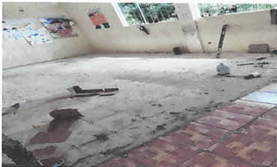
Sustitución de piso cerámico en tres aulas del segundo nivel (56 m2)
