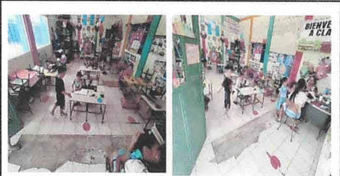
Sustitución de piso cerámico en dos aulas del primer nivel (75 m2)
