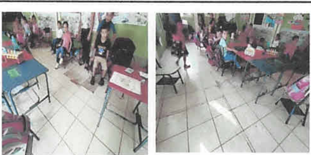
Sustitución de piso cerámico en dos aulas del primer nivel (75 m2)
