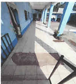
Sustitución de piso cerámico en el corredor del primer nivel (78 m2)
