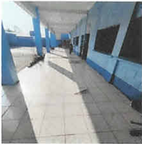
Sustitución de piso cerámico en el corredor del primer nivel (78 m2)
