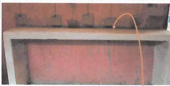
Sustitución de mesa de trabajo en cocina fundida de concreto de 2.75 m x 0.60 m
