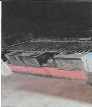
Sustitución de 1 parrillas de metal de 0.75x 0.80 mts
