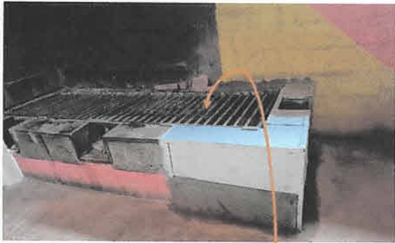
Sustitución de 1 parillas de metal de 0.75x 1.75 mts
