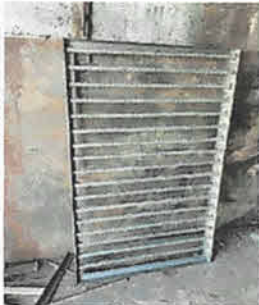
Sustitución de 1 parrillas de metal de 0.75x 0.80 mts
