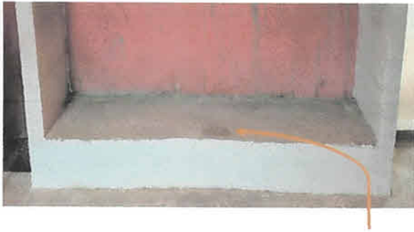
Sustitución de mesa de trabajo en cocina fundida de concreto de 3.75 x 0.40 mts mas base
