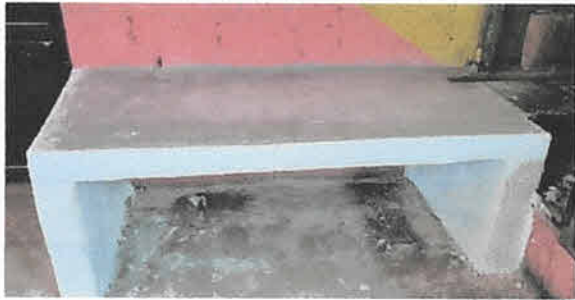
Sustitución de mesa de trabajo en cocina fundida de concreto de 3.75 x 0.60 de ancho mas bases
