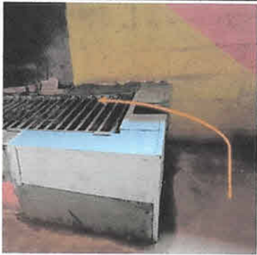
Mantenimiento de 1 polleton en cocina de 3.10 X 1.25 mt, con angular de 1 1/2" por 3/16" de grosor.
